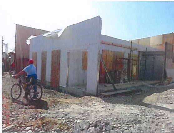
Cierre acústico en área de construcción salón de eventos y quincho
