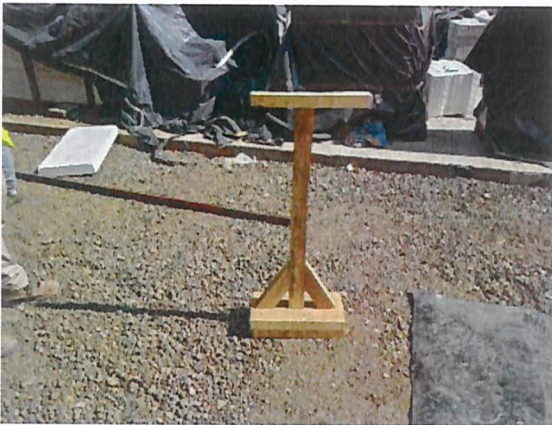
Uso de compactadora manual
