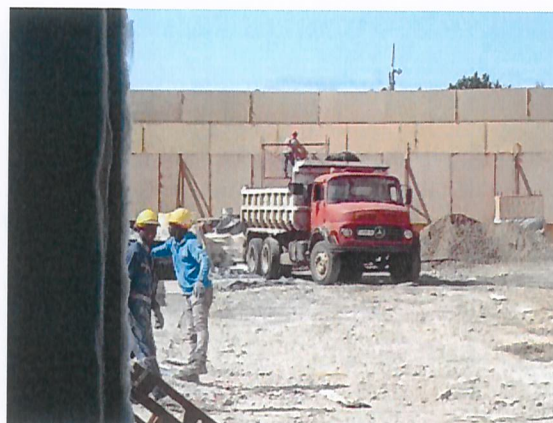
Circulación de camión tolva para retiro de escombros (cuando se estaciona, motor se apaga)
