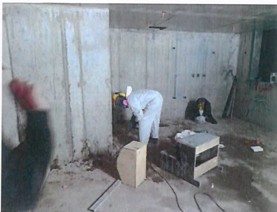
Uso de cangos y taladros interior de torre B
