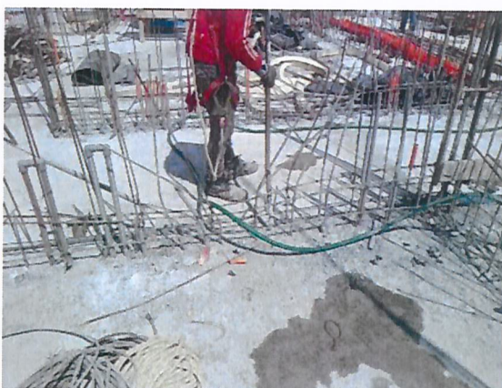
Uso de chuzo en losa en altura, en último piso de torre B
