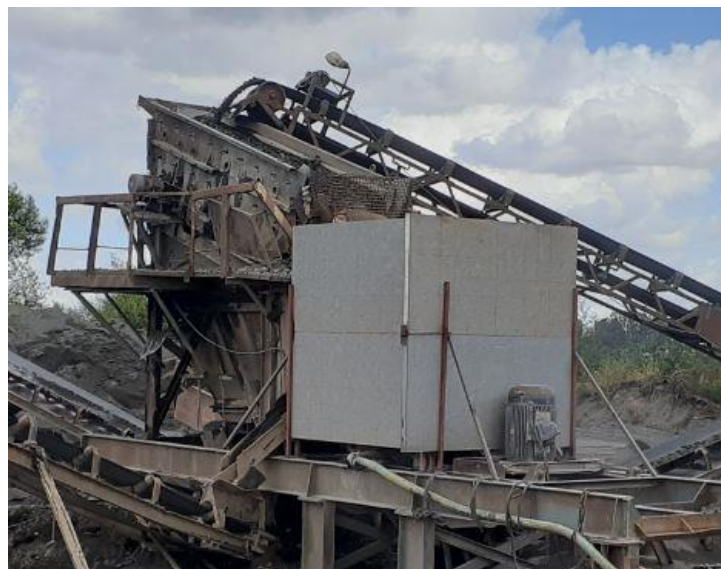
Imagen implementación barreras acústicas
