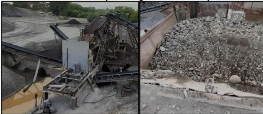
Figura N° 5 Barrera acústica y amortiguamiento de impacto de material
