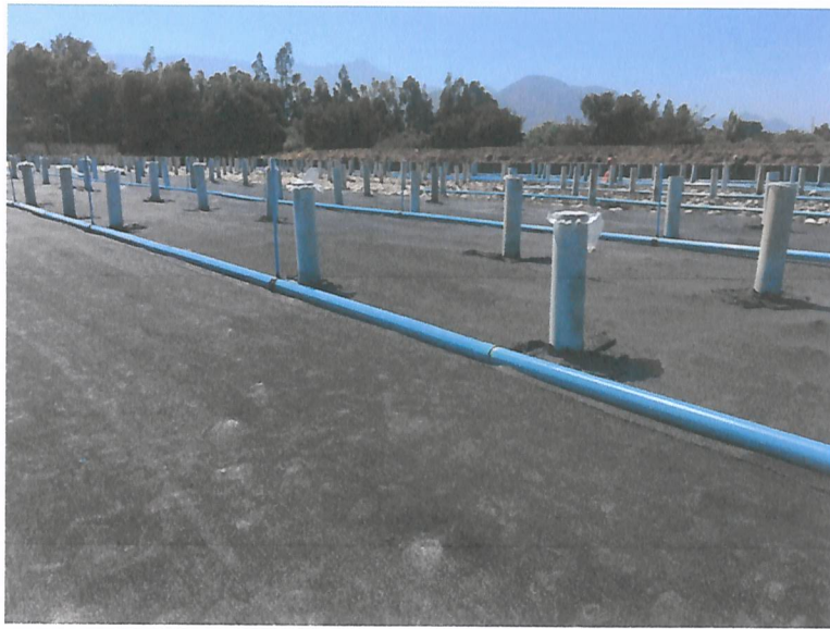
Fotografía 5 Fecha: 28 de noviembre de 2018 Coordenadas DATUM WGS84, Huso 19 Este: 292.715 m Norte: 6.380.247 m Descripción: En la imagen se muestra la peusta de malla raschel y piping totalmente nuevo sobre el lecho del biofiltro para comenzar el relleno con viruta.
