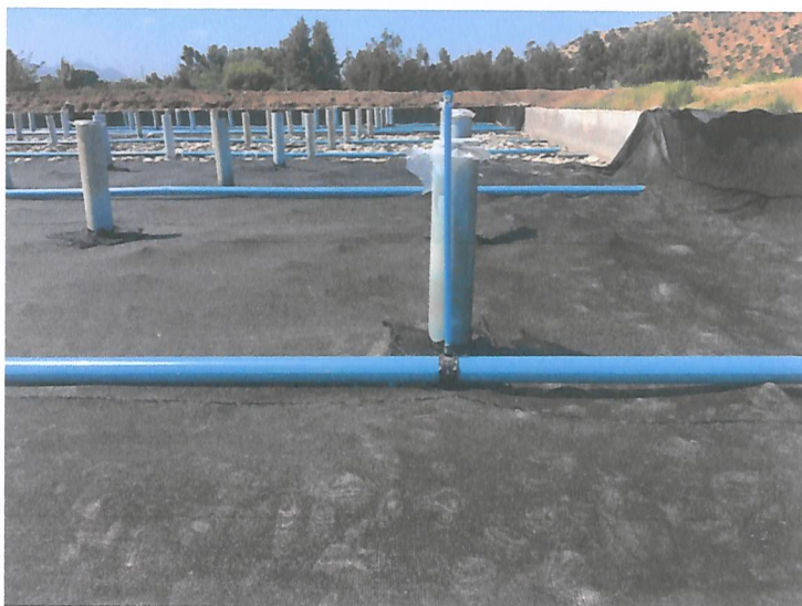
Fotografía 6 Fecha: 7 de mayo de 2018 Coordenadas DATUM WGS84, Huso 19 Este: 292.722 m Norte: 6.380.247 m Descripción: Detalle de instalación de piping sobre malla raschel. En la imagen se aprecia el collarín instalado en la matriz de impulsión de aguas servidas, así como también la tubería de 1" que sirve como aspersion.
