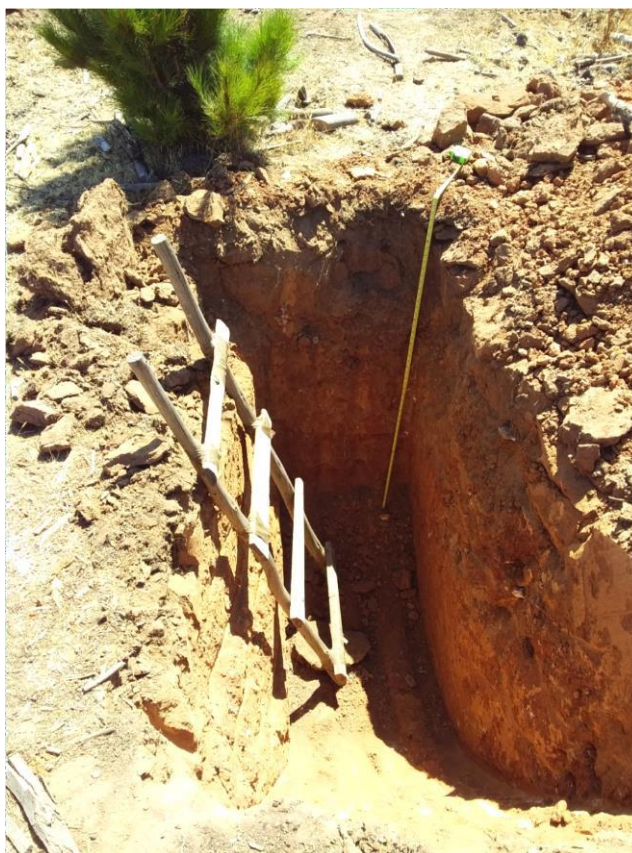
Fotografía 9. Detalle de Calicata C3.
