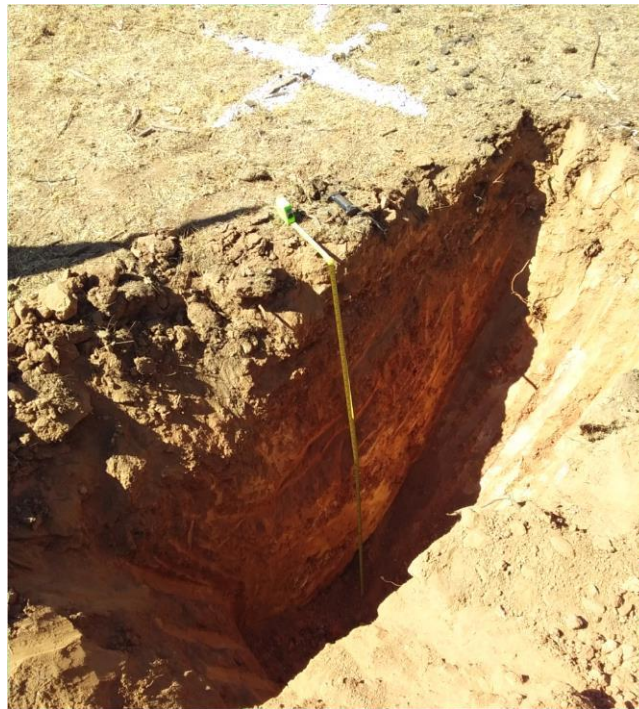
Fotografía 5. Detalle de Calicata C1.
