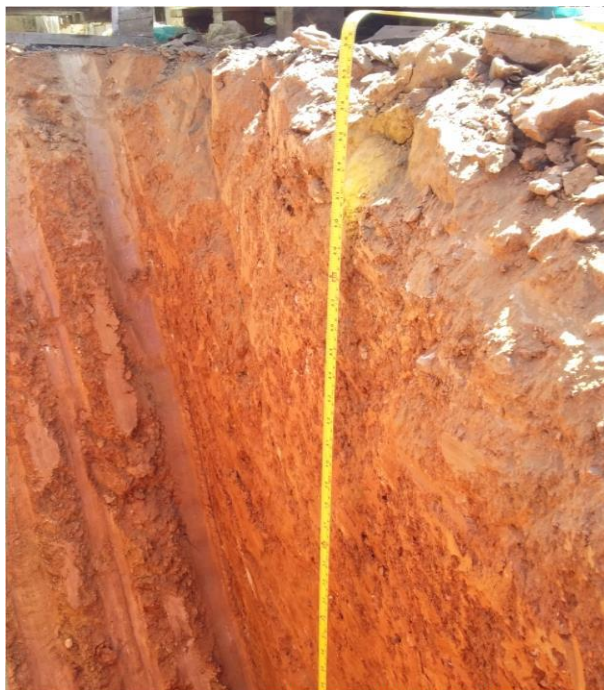
Fotografía 19. Detalle de Calicata C8.
