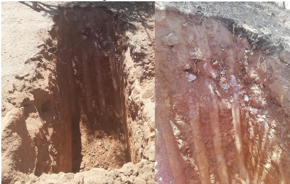
Fotografía 17. Detalle de Calicata C7.
