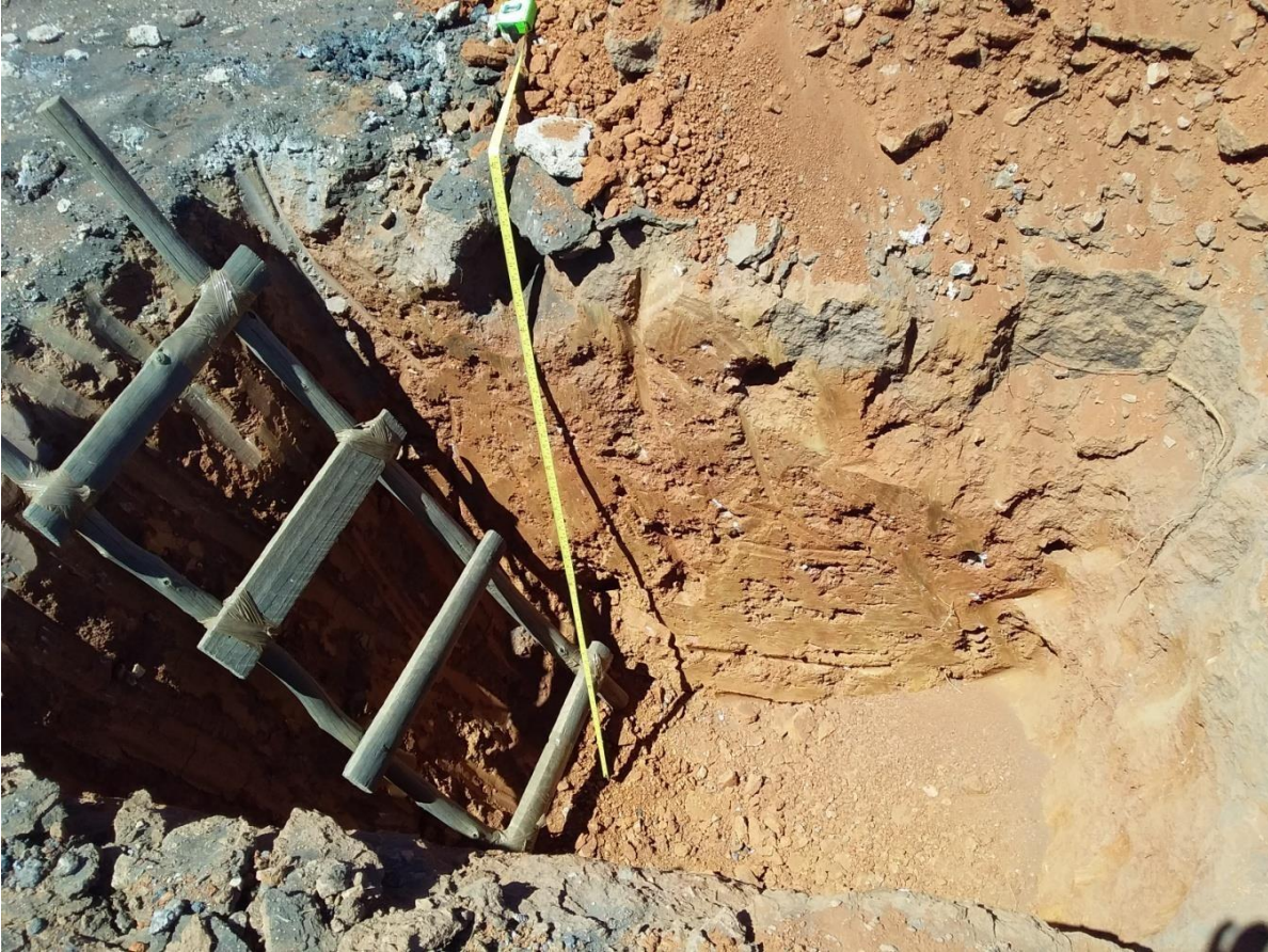
Fotografía 13. Detalle de Calicata C5.
