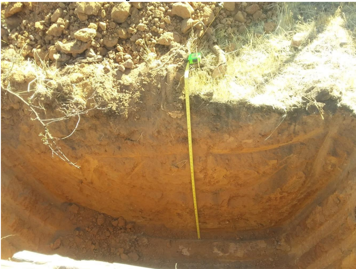
Fotografía 35. Detalle de Calicata C16.
