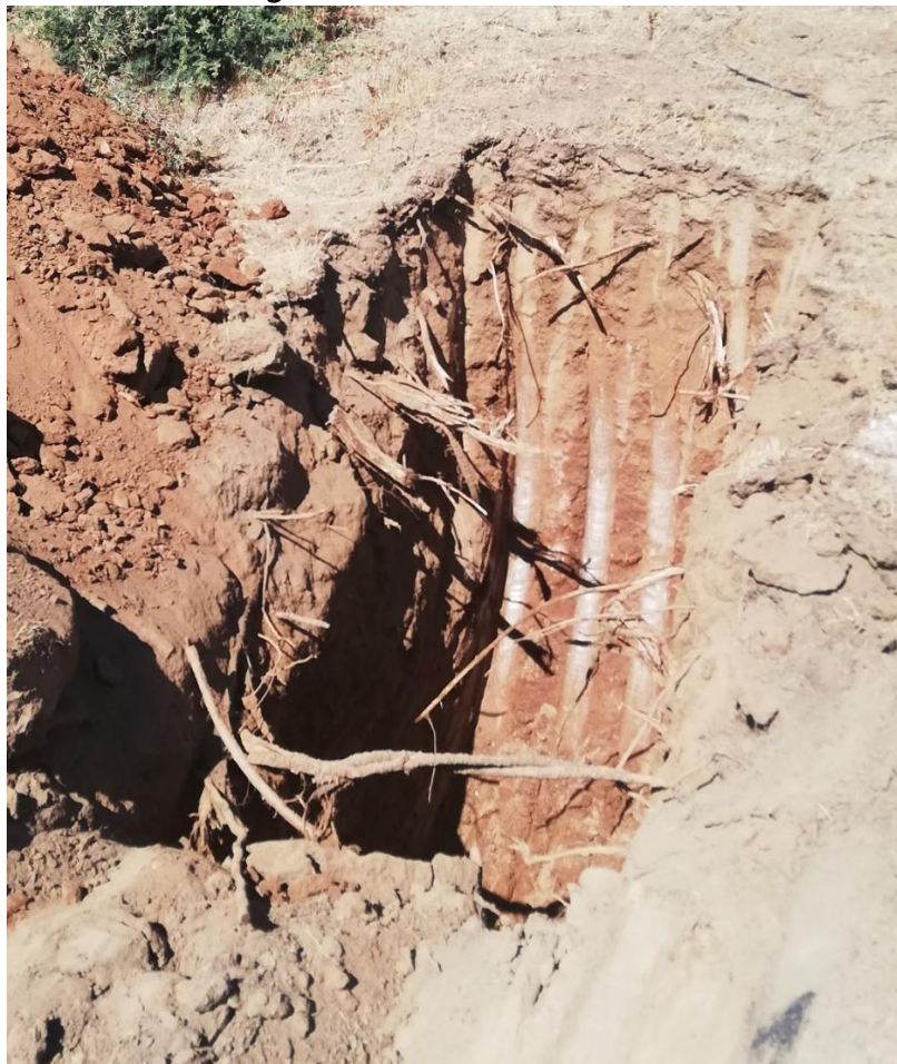
Fotografía 51. Detalle de Calicata C24.
