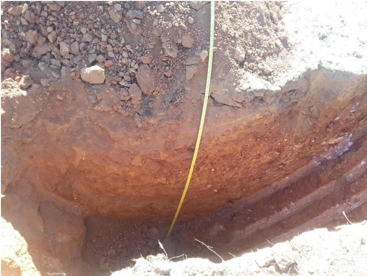
Fotografía 33. Detalle de Calicata C15.
