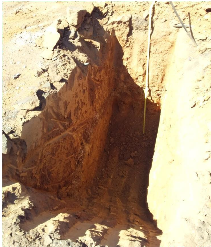
Fotografía 21. Detalle de Calicata C9.
