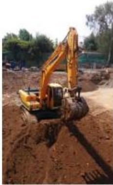
**Foto 8** Proceso excavación con Excavadora Hyundai, modelo 220LC-95.
