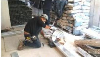
**Foto 45:** Tronzadora Bauker, corte de perfiles 150
