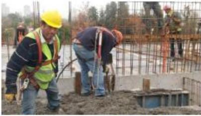
**Foto 28:** Hormigonado de muro con sonda vibratoria Wacker Neuson.
