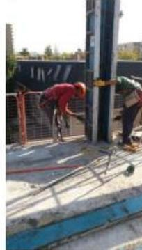
**Foto 18:** Proceso colocación pernos de amarre en moldaje pilares.
