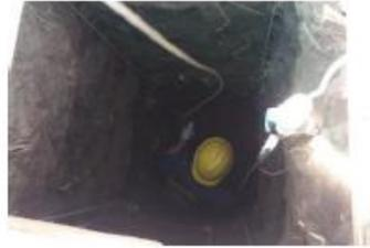
Foto 2: Proceso excavación de pila con cango, cuadrilla 2 .
