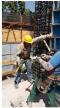
**Foto 22:** Proceso nivelación de moldaje de muro con combo.
