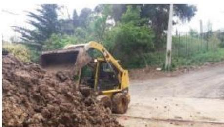
Proceso traslado de material con Mini Cargador Cat, modelo 225B3 cabina abierta.
