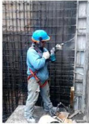
**Foto 43:** Corte de moldaje en descimbre con cango Makita, modelo HM0810T.
