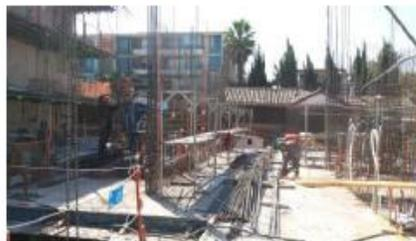
**Foto 15** Armado manual de enfierradura de muro y cortador de hierro cercano.
