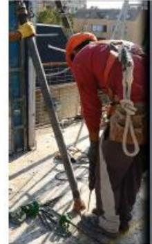
**Foto 20:** Proceso perforación losa para fijación alzaprima para moldaje pilares.
