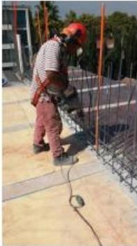
**Foto 31:** Proceso tratamiento de junta losa con Cango Bosh modelo Boschhammer.
