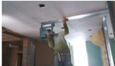
**Foto 46:** Pistola a Gas VAF, clavado de perfiles a losa de hormigón.
