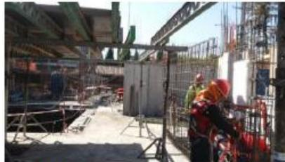
**Foto 37:** Proceso canalización eléctrica de muro.
