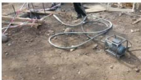
Motor Taurus sonda vibratoria para vibrado del hormigón en pilas.
