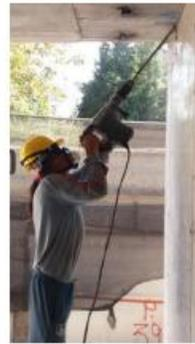
**Foto 33:** Proceso descarachado de muro con Cincelador eléctrico, modelo Boschhammer.
