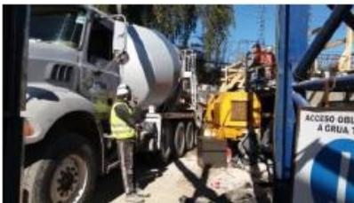
**Foto 25:** Proceso operación bomba de hormigón Putzmeister para hormigonado de losa.
