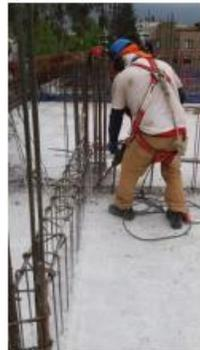
**Foto 32:** Proceso tratamiento de junta losa con Cango Makita modelo MH1203C.
