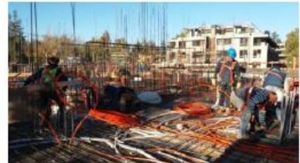
**Foto 38:** Proceso canalización eléctrica de en losa.
