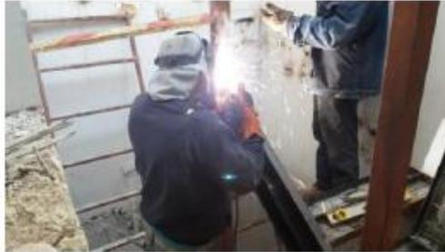
Foto 55: Soldadura al arco perfiles escalera metálica
