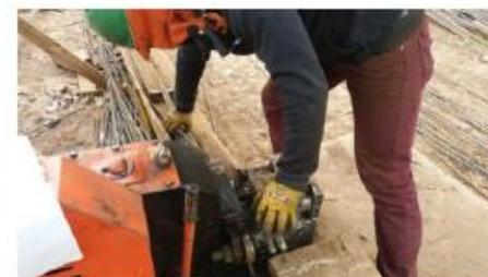
Dimensionado de fierros con Cortadora Cizalla eléctrica
