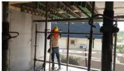
**Foto 29:** Proceso descimbre de losa: soltado de tuercas de torreta de encofrado.
