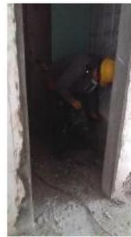
**Foto 34:** Proceso picado de losa con Cincelador eléctrico, modelo Boschhammer.
