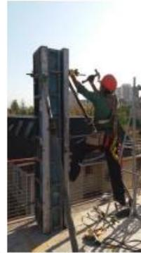
**Foto 19:** Proceso colocación de tuercas a pernos de amarre en moldaje pilares.
