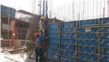
**Foto 21:** Proceso fijación de tuercas pernos de amarre con martillo en moldaje de muro.
