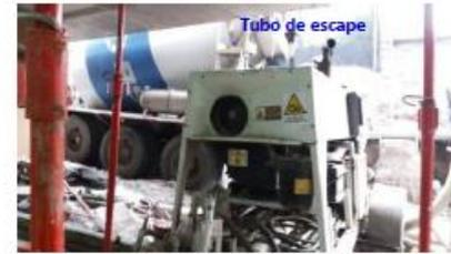
**Foto 27:** Proceso operación bomba de hormigón Schwing para hormigonado de muro con capacho
