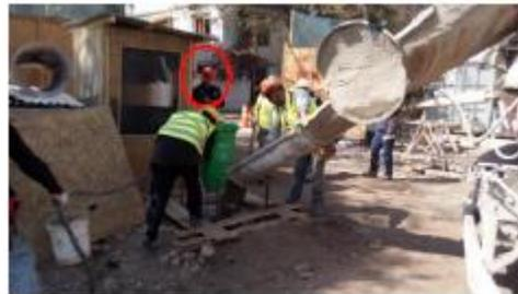
Foto 7: Recepción camión mixer y observación vaciado de hormigón a pilas.
