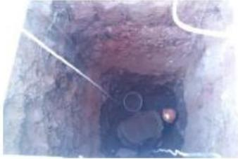
Foto 1: Proceso excavación de pila con cango, cuadrilla 1 .
