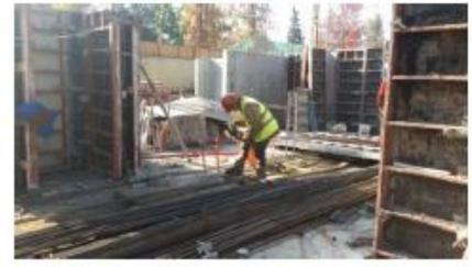
**Foto 13:** Dimensionado de fierros con esmeril angular Makita modelo GA-9020.
