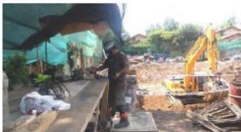
Proceso doblado manual de fierros con influencia de Excavadora y acopio en tambor metálico..
