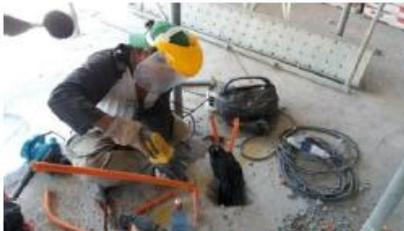
**Foto 36:** Proceso perforación para readaptación de tabiques de canalización eléctrica con Taladro Percutor Stanley.
