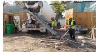
Foto 6: Camión mixer con elevación de rpm del cono.
