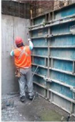
**Foto 42:** Descimbre de moldaje de muro con martillo manual.
