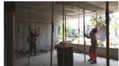
**Foto 30:** Proceso colocación alzaprimas post descimbre.
