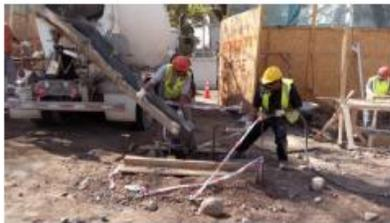
Foto 4: Proceso hormigonado de pilas, vaciado y vibrado del hormigón.
