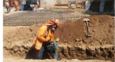
**Foto 10:** Proceso picado de tierra con Cango Bosch modelo Boschhammer para construcción de zanja.
