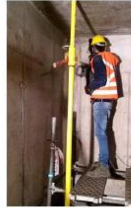
**Foto 44:** Reparación de muro cielo subterráneo, con cango Makita, modelo HM1203C.
