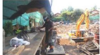
Foto 3: Proceso doblado manual de fierros con influencia de Excavadora y acopio en tambor metálico.
