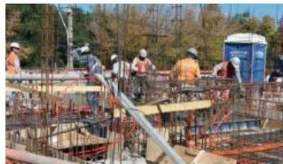
**Foto 26:** Hormigonado de losa con sonda vibratoria sin marca y modelo.
