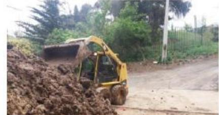
**Foto 41:** Proceso traslado de material con Mini Cargador Cat, modelo 225B3.
