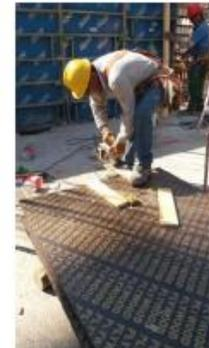
**Foto 24:** Proceso corte de madera de pino con sierra circular Stanley para moldaje de muro
