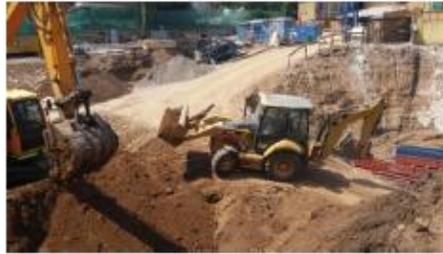
**Foto 9:** Proceso movimiento de tierra con Retroexcavadora Caterpillar, modelo 416E.
