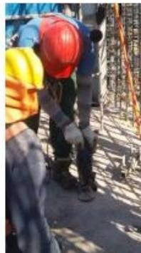
**Foto 23:** Proceso perforación losa para fijación alzaprima para moldaje muro
