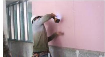
**Foto 47:** Atornillador DeWalt XR, atornillado placas de yeso a estructura perfil 150.
