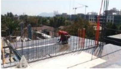
**Foto 17:** Proceso clavado de placas de madera fenólica armado moldaje de losa.
