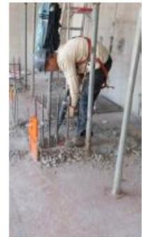
**Foto 35:** Proceso picado de losa con cango Bosch modelo GSH 5.
