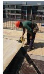
**Foto 16** Dimensionado de placas fenólicas para moldaje losa.
