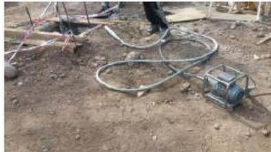
Foto 5: Motor Taurus sonda vibratoria para vibrado del hormigón en pilas.
