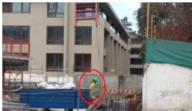
**Foto 39:** Proceso coordinación movimiento de carga, con silbato.
