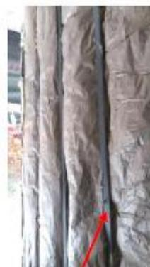
Perfiles de metalcom recubiertos con banda de material elástico.
