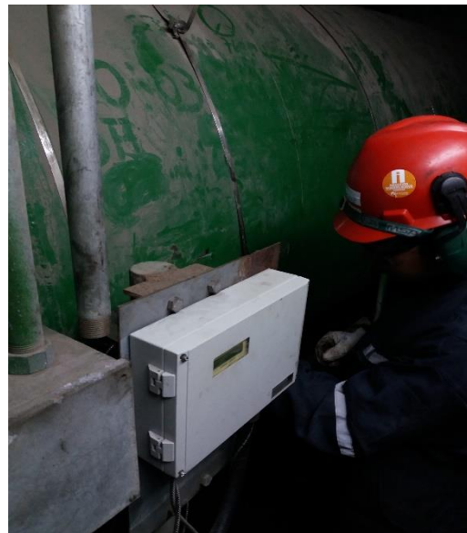
Trabajos de mantenimiento preventiva y/o correctiva. Pantalla de Flujoímetro FLEXIM.
