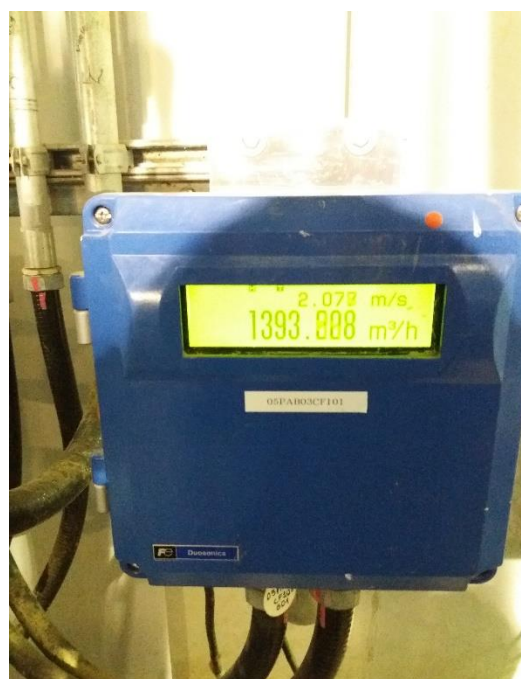
Trabajos de mantenimiento preventiva y/o correctiva. Pantalla de Flujómetro DUOSONIS.
