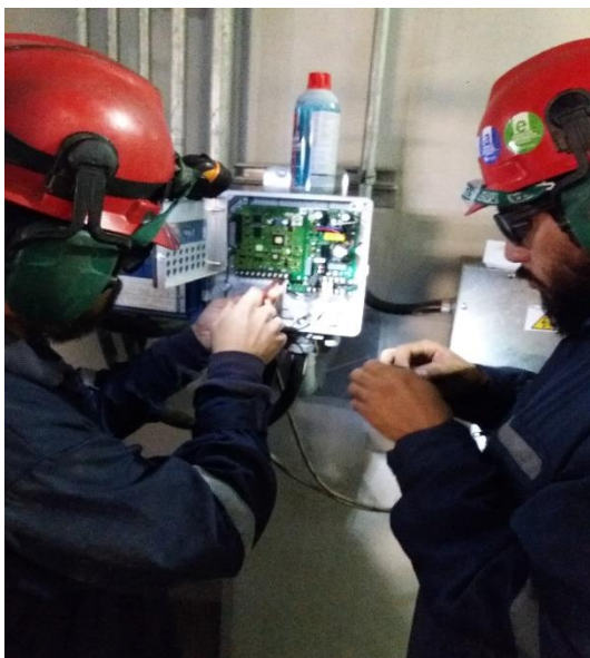
Trabajos de mantenimiento preventiva y/o correctiva. Pantalla de Flujoímetro FLEXIM.
