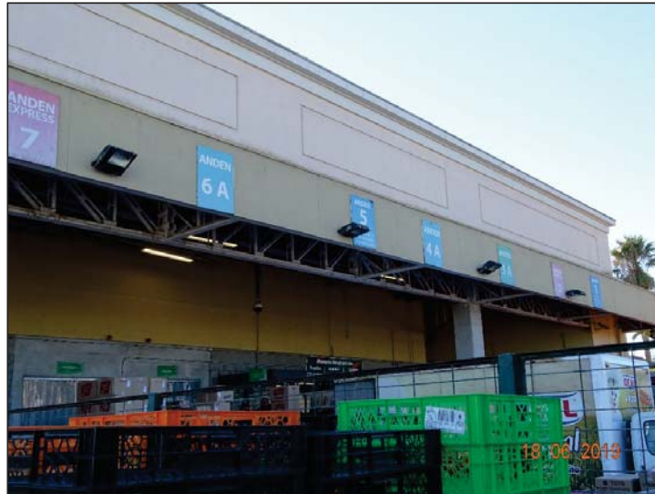
Fuente: Informe de Fiscalización DFZ-2019-2121-IV-NE, Fotografía 5.
