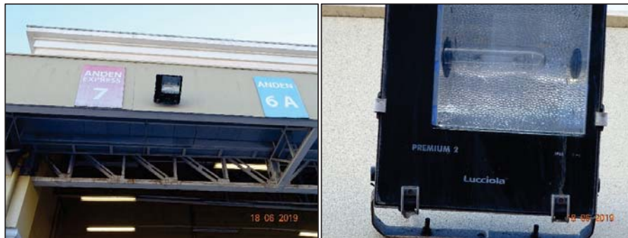
Fuente: Informe de Fiscalización DFZ-2019-2121-IV-NE, Fotografías 4 y 6.
