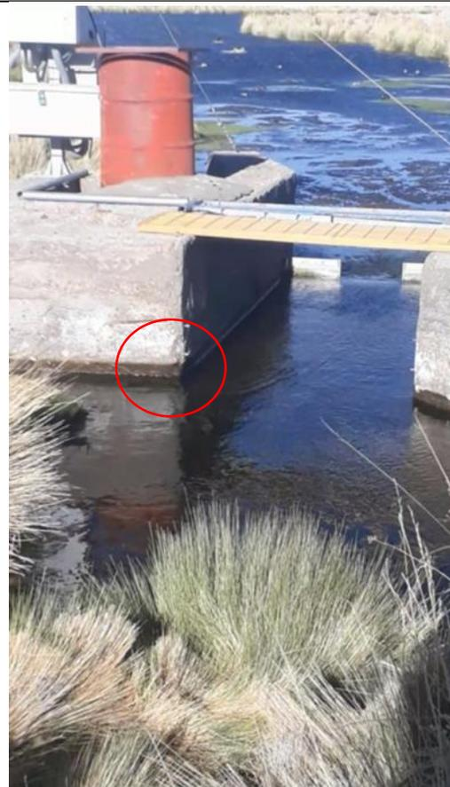
Imágenes de fecha 06/10/2019 en la que se observa a la vertiente Jacho Coposa sin mitigación, se evidencia una disminución importante del nivel de agua que pasa por el vertedero (línea roja, denota el cambio en el nivel del agua que pasa por el vertedero).
