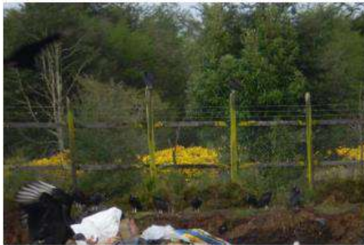
Figura .9. Vista del cierre desde el sur poniente.
