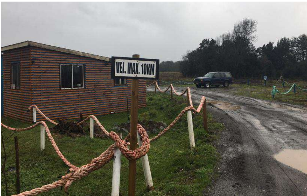
Fig. 2. Oficinas y estacionamientos para vehículos menores al interior del VID.
