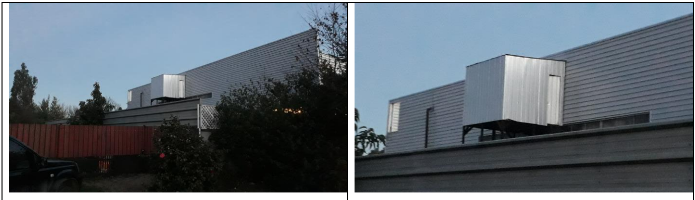
Ilustración 1: Fotografías de instalación de encierro acústica perimetral.
