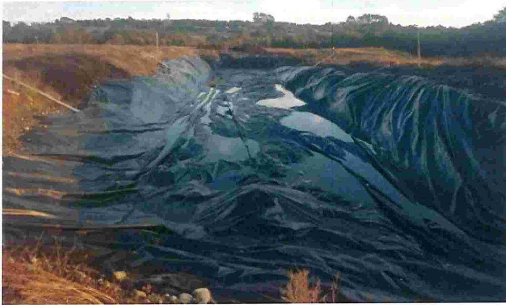
Imagen N°2: Zanja activa N°34
