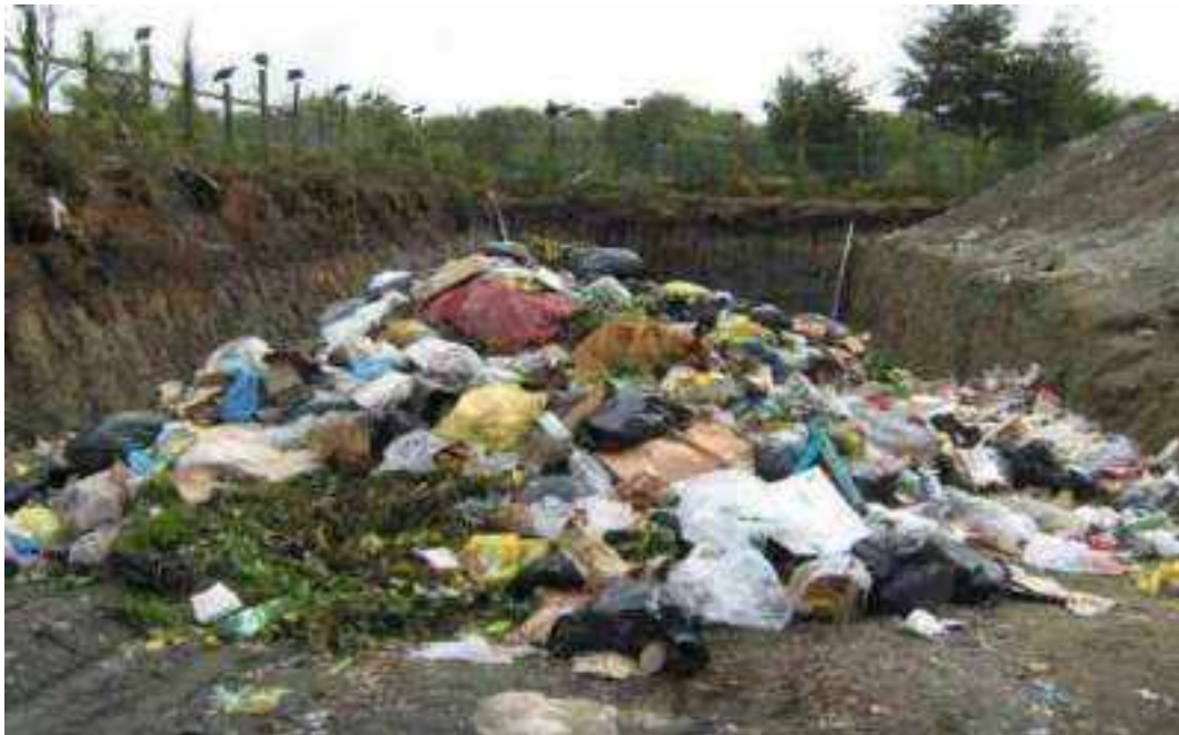
Fig. 25: Zanjas sin impermeabilizar donde es depositado los residuos sólidos domiciliarios en el vertedero municipal de Chonchi. Fotografía 13 tomada de la DIA del año 2009 respecto del proyecto denominado “Plan de Cierre y Sellado Vertedero Municipal Comuna de Chonchi.
