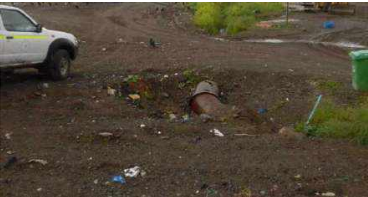
Fig. 21: Encausamiento por tuberías del tributario que ingresa al vertedero municipal por el lado este. (Georreferenciación: 5280104.08 S; 595047.96 E). Fotografía tomada el 13/12/2019.
