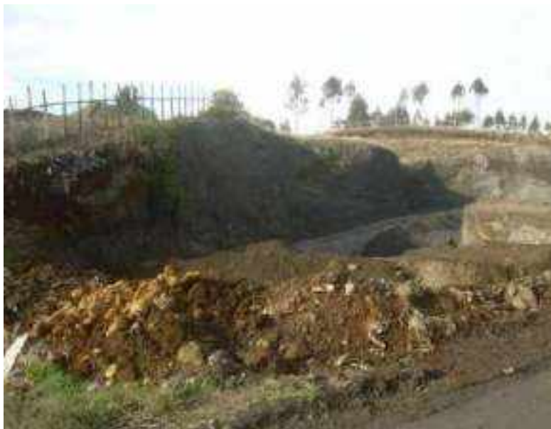
Figura .10. Vista del cierre desde el acceso al vertedero.
