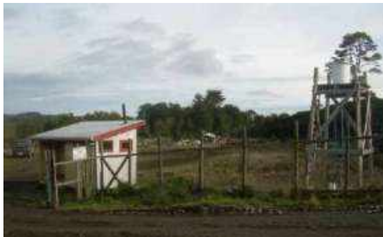
Figura .12. Vista de caseta de Vigilancia Vertedero
