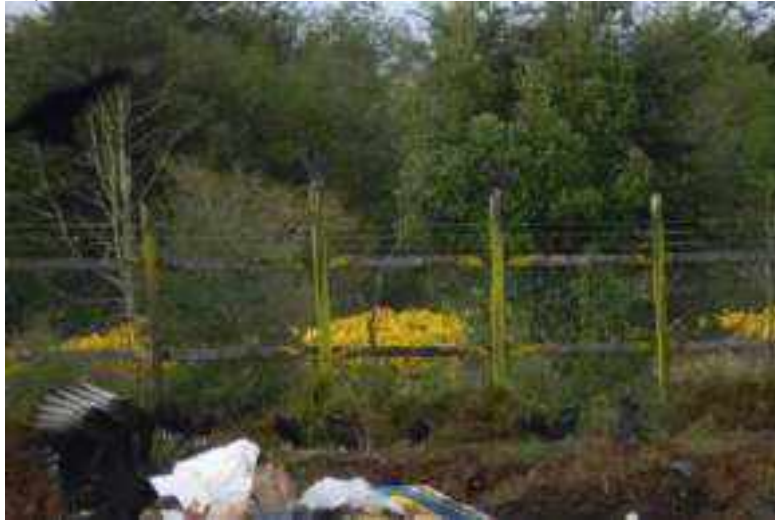
Figura .9. Vista del cierre deslinde sur poniente.
