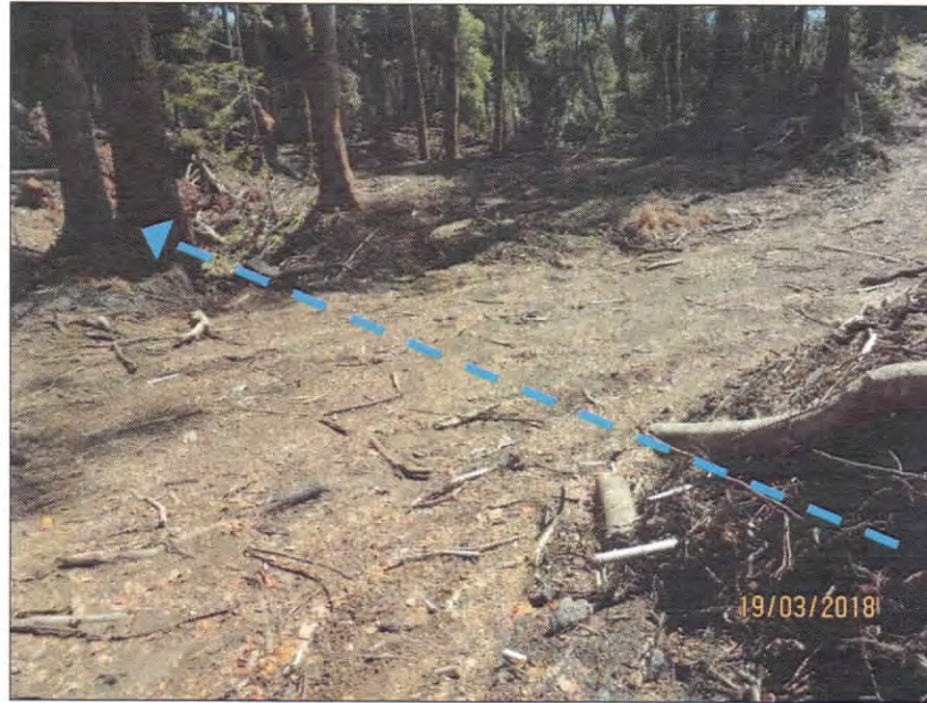
Imagen 1. Terraplén construido sobre brazo del cauce natural.
