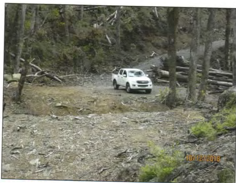
Imagen 1. Eliminación terraplén construido sobre brazo del río Trancura.
