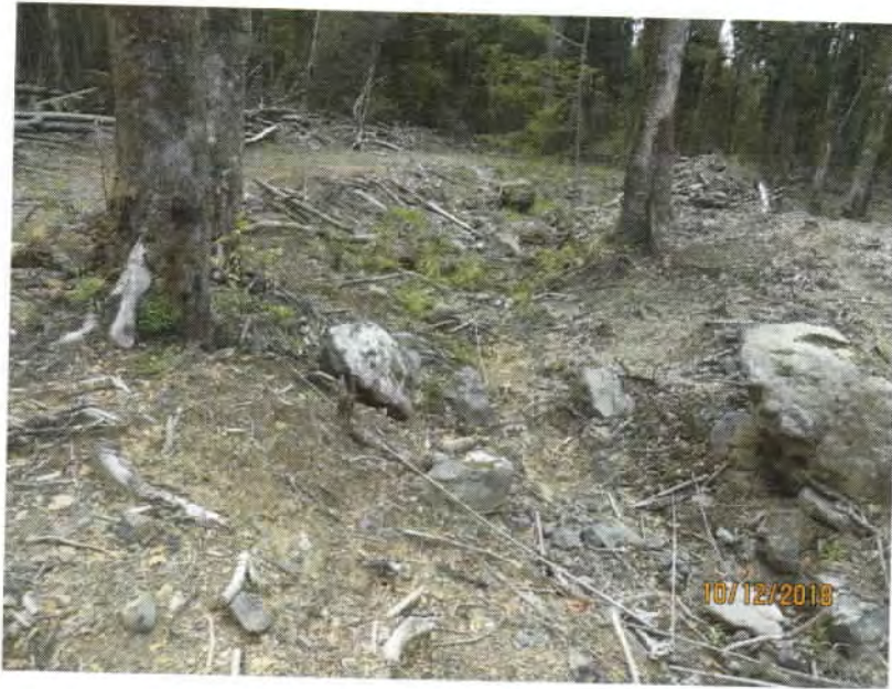
Imagen 2. Eliminación del segundo acopio observado sobre brazo del cauce natural.
