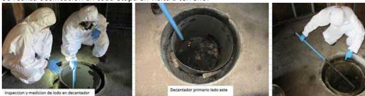
Imagen N°5 – Medición de Cámaras.
