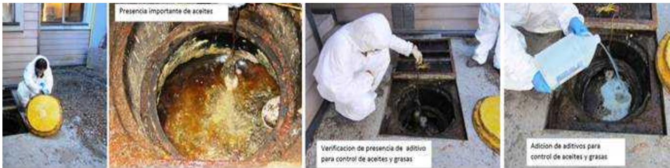
Imagen N°2 – Revisión Cámara desgrasadora (grasa sólida).
