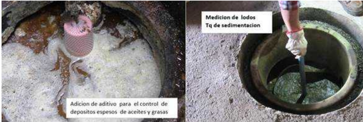
Imagen N°5 – Medición de Cámaras.
