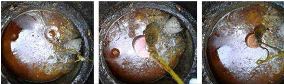
Imagen N°09 – Cámara desgrasadora con uso de bacterias.
