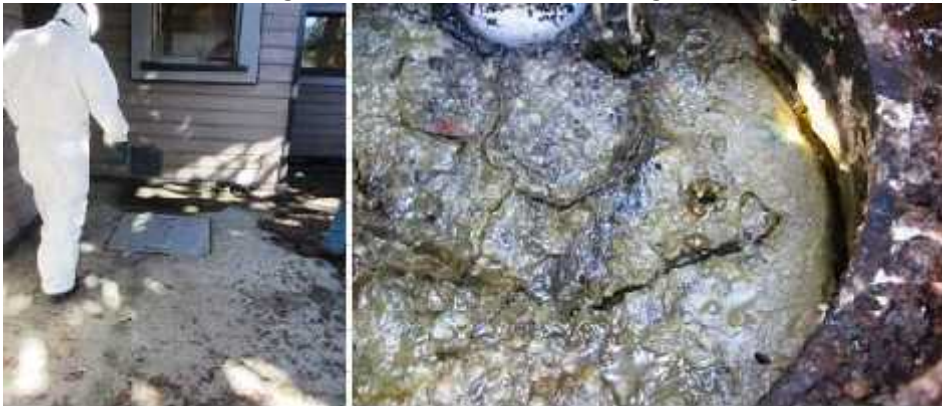
Imagen N°2 – Revisión Cámara desgrasadora (grasa solid).
