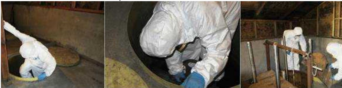
Imagen N°5 – Medición de Cámaras.
