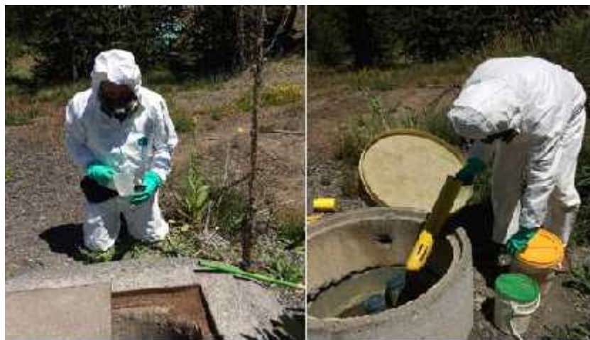
Imagen N°6 – Relleno Dispensadores de tabletas cloradoras y de cloradoras.
