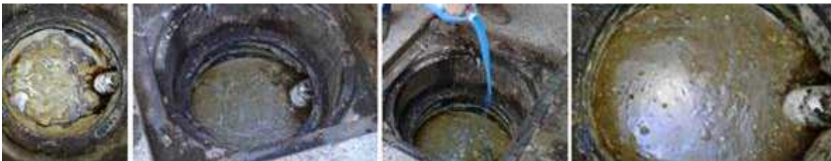
Imagen N°2 – Trabajos de limpieza en desgrasador.
