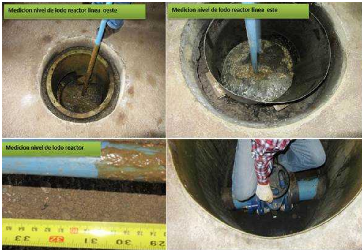
Imagen N°5 – Medición de Cámaras.
