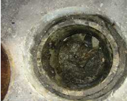
Imagen N°5 – Medición de Cámaras.
