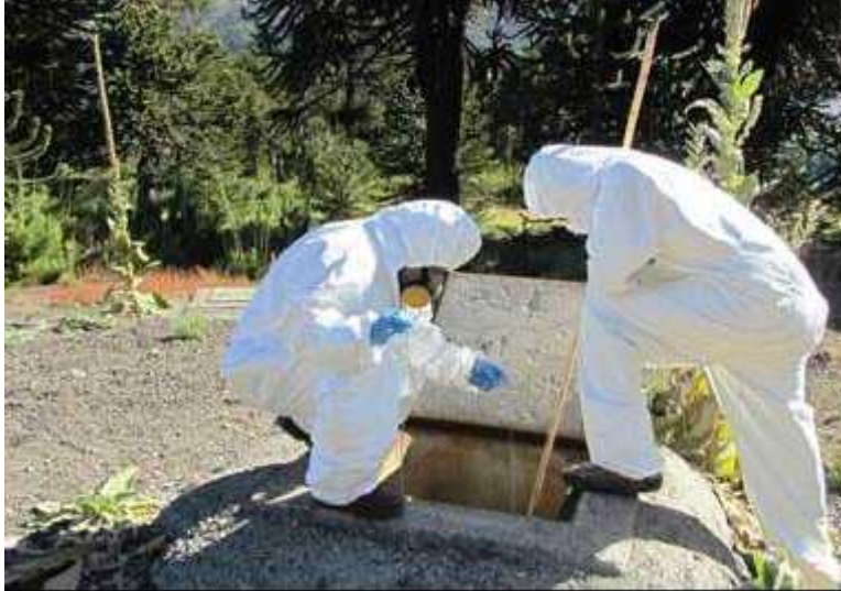
Imagen N°6 – Relleno Dispensadores de tabletas cloradoras y decloradoras.
