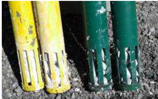
Imagen N°6 – Relleno Dispensadores de tabletas cloradoras y de cloradoras
