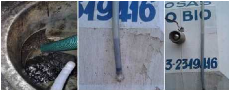
Imagen N°3 – Limpieza de cámara decantadoras.
