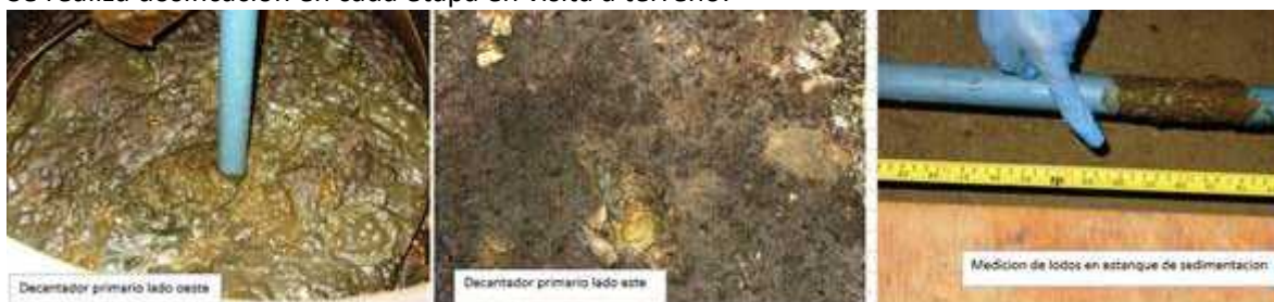
Imagen N°5 – Medición de Cámaras.
