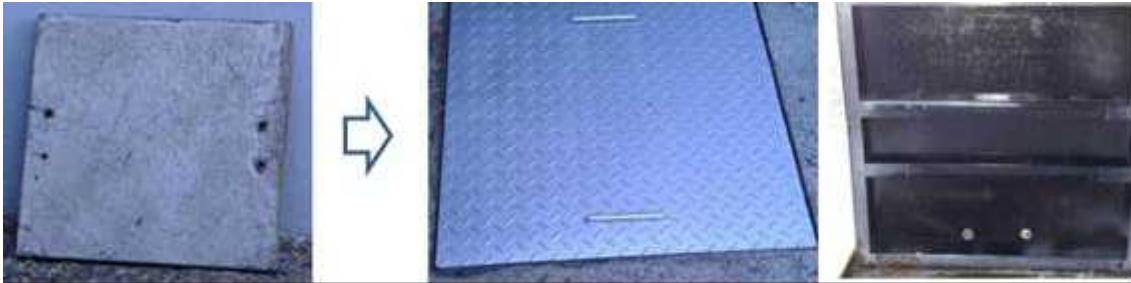
Imagen N°8 – Cambio Tapa desgrasador.
