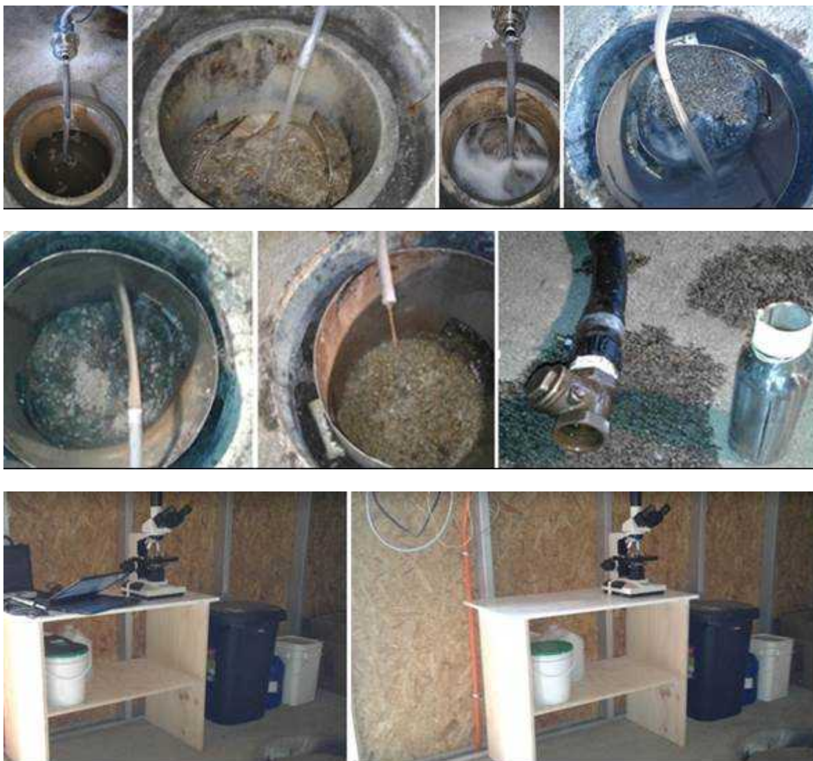
Imagen N°7 – Recirculación desde reactor a cámaras decantadoras y se instala filtro de succión, se instala equipo microscopia para capacitación en planta y control de bacterias.
