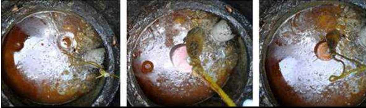
Imagen N°09 – Camara desgrasadora con uso de bacterias.
