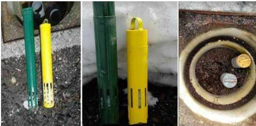
Imagen N°6 – Relleno Dispensadores de tabletas cloradoras y decloradoras.
