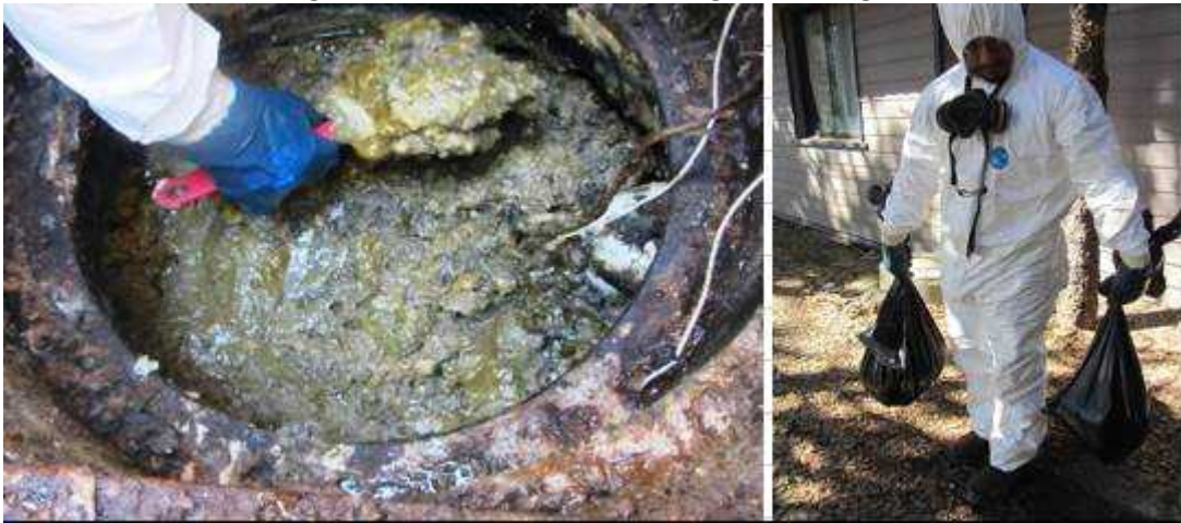
Imagen N°2 – Revisión Cámara desgrasadora (grasa solid).
