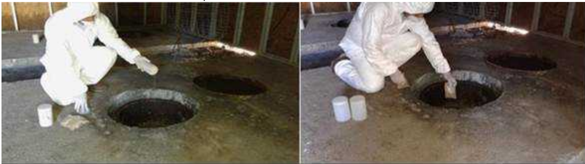
Imagen N°5 – Medición de Cámaras.
