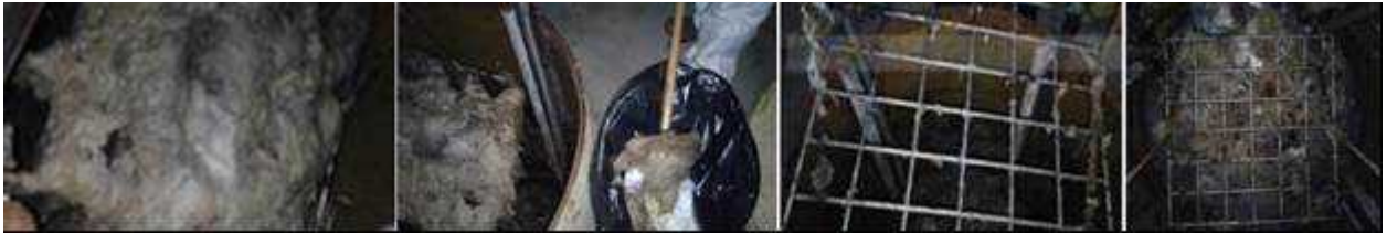
Imagen N°3 – Limpieza de cámara de desbaste.
