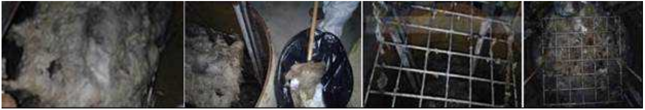
Imagen N°3 – Limpieza de cámara de desbaste.
