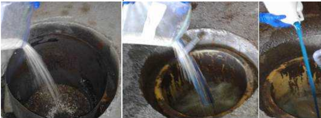
Imagen N°5 – Medición de Cámaras.
