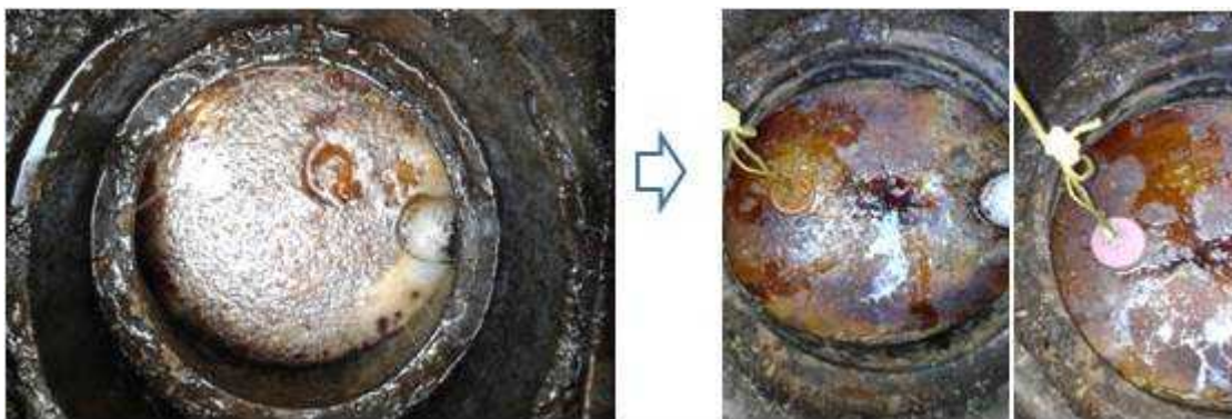
Imagen N°09 – Refuerzos de bacterias en desgrasador.
