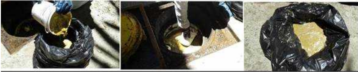
Imagen N°2 – Revisión Cámara desgrasadora (grasa solida).
