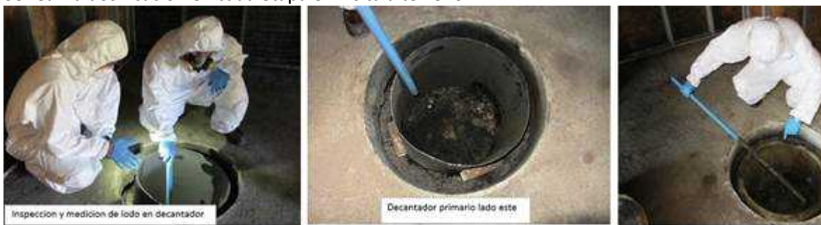
Imagen N°5 – Medición de Cámaras.
