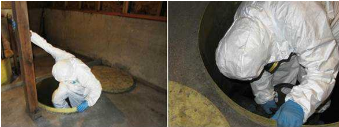
Imagen N°5 – Medición de Cámaras.
