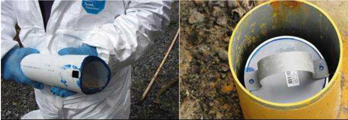
Imagen N°6 – Relleno Dispensadores de tabletas cloradoras y decloradoras.
