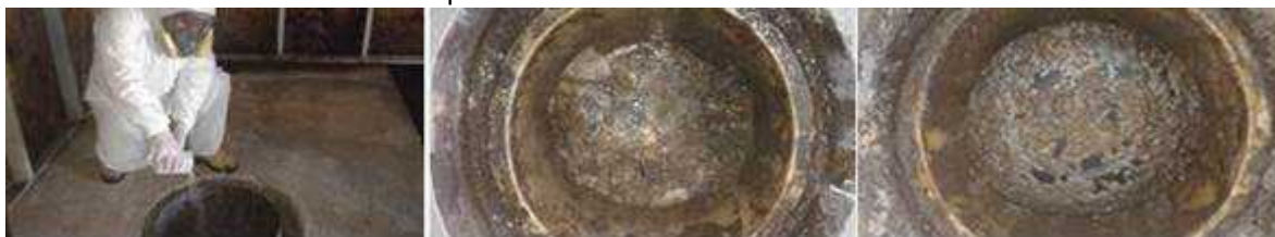
Imagen N°4 – Medición de Cámaras.
