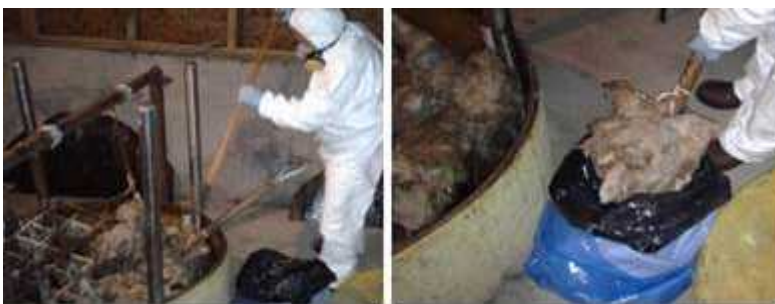
Imagen N°2 – Limpieza de cámara decantadoras.
