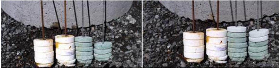
Imagen N°6 – Relleno Dispensadores de tabletas cloradoras y de cloración. Se modifican dispensadores para mejorar el contacto con la Cloración/De cloración del agua tratada.
