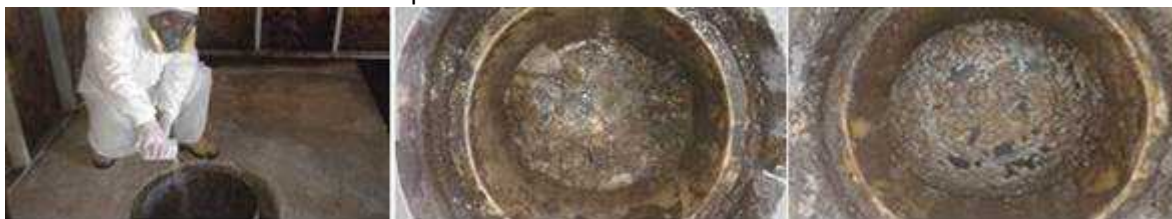
Imagen N°4 – Medición de Cámaras.
