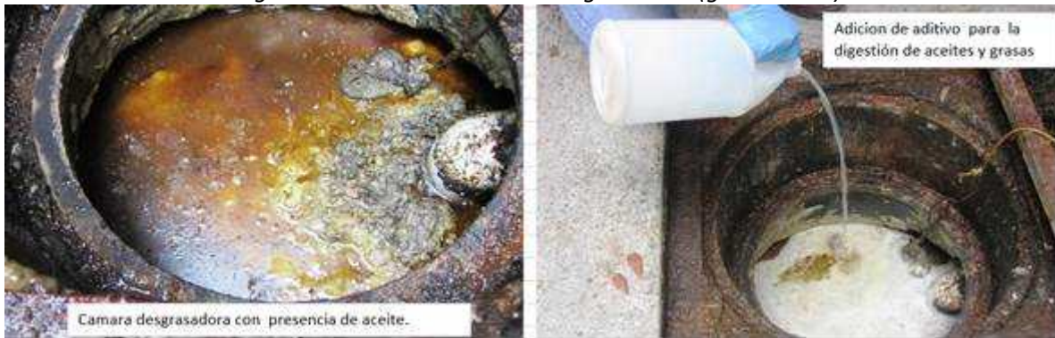
Imagen N°2 – Revisión Cámara desgrasadora (grasa solid).
