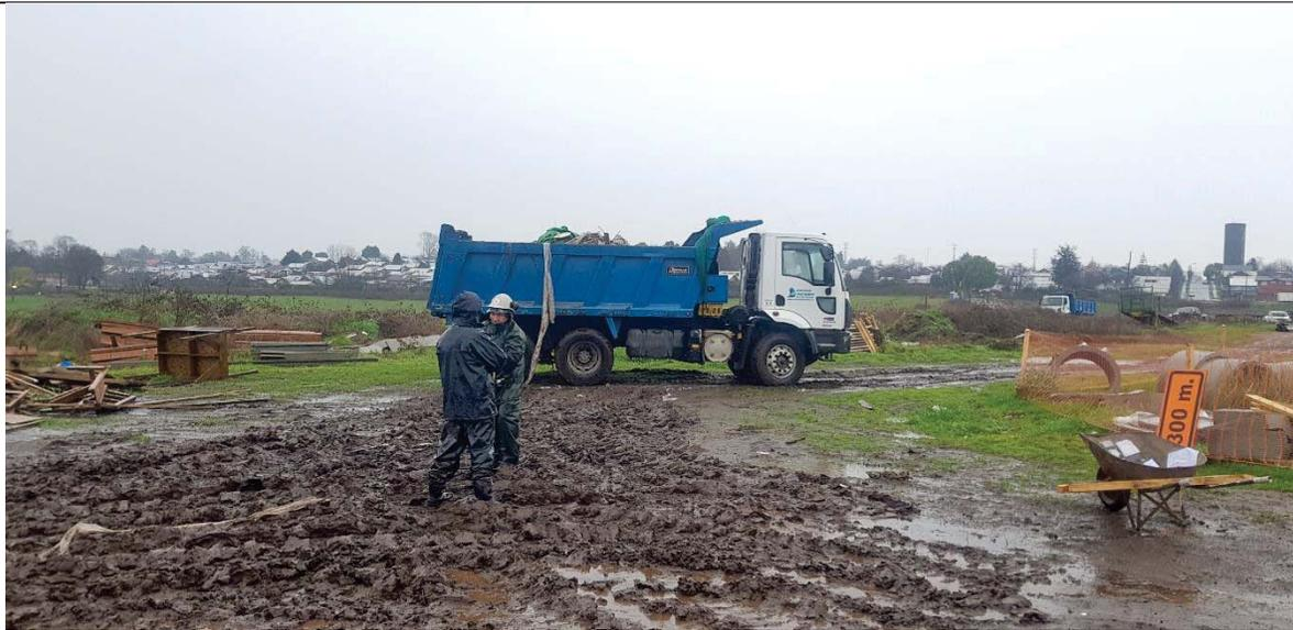
Foto 2. A la derecha malla naranja de cerco provisorio, instalado para el retiro de escombros.
