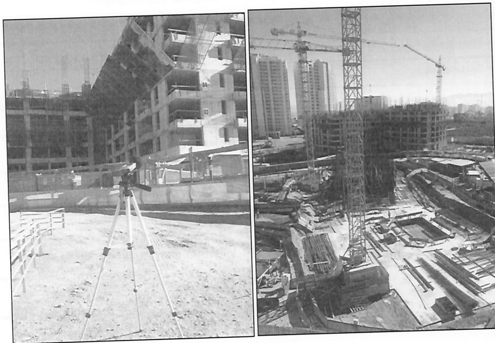
Ilustración N°1 y N°2. Vista general del interior de la obra
