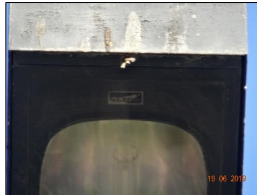
Fotografía 5 Fecha: 19-06-2019 Fotografía 6 Fecha: 19-06-2019 Coordenadas UTM DATUM WGS84 HUSO 19s Norte: 6.970.375 mS Este: 369.851 mE Coordenadas UTM DATUM WGS84 HUSO 19s Norte: 6.970.409 mS Este: 369.900 mE Descripción del medio de prueba: Vista de poste con luminarias SAP, marca Tecnoluce. Descripción del medio de prueba: Vista detalle de luminaria SAP, marca Tecnoluce.
