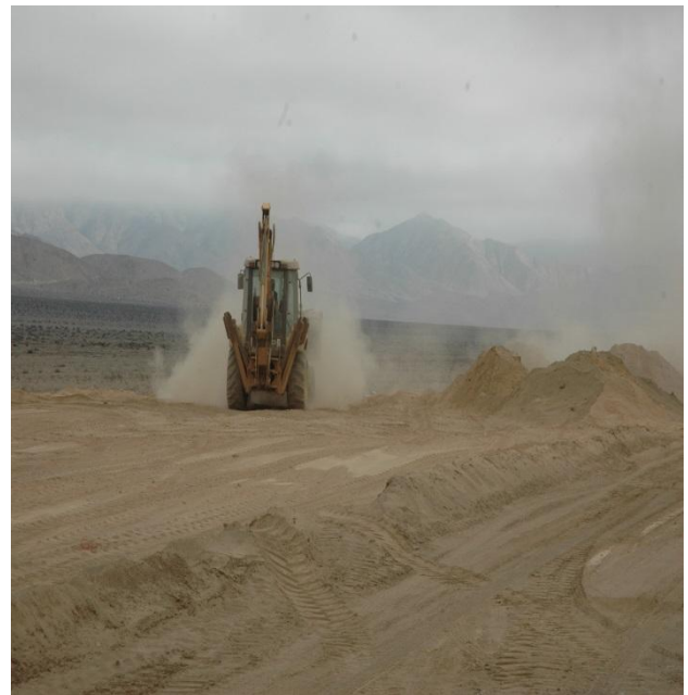
Figura 33: Las imágenes superiores detallan la extracción del material edáfico utilizando retroexcavadora y las inferiores el acopio del escarpe utilizando una miniretroexcavadora. La imagen superior derecha detalla el acopio temporal sobre malla de geotextil, en cambio, las imágenes restantes el acopio en áreas denudadas dentro de la franja de servidumbre (luego del pretil del camino=polígonos de revegetación).
