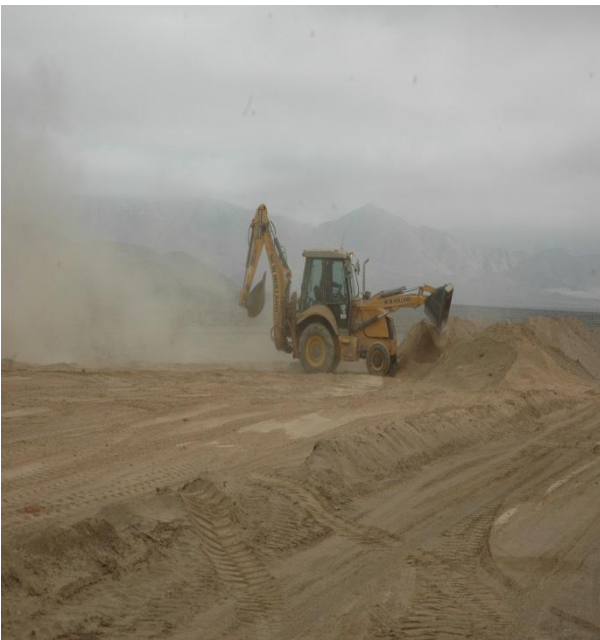
Figura 33: Las imágenes superiores detallan la extracción del material edáfico utilizando retroexcavadora y las inferiores el acopio del escarpe utilizando una miniretroexcavadora. La imagen superior derecha detalla el acopio temporal sobre malla de geotextil, en cambio, las imágenes restantes el acopio en áreas denudadas dentro de la franja de servidumbre (luego del pretil del camino=polígonos de revegetación).
