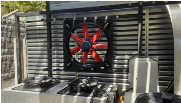
Figura N° 6 – Adición de pulverización y riego de enfriamiento, más extractores de calor
