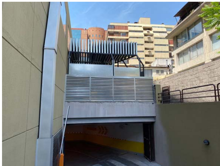
Figura N° 10 – Avance actual de los trabajos.
