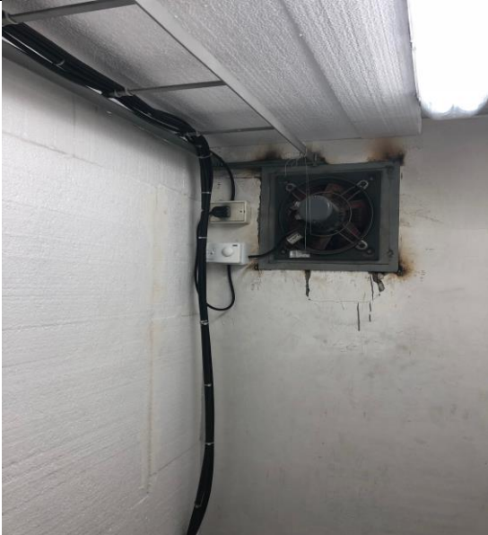
Instalacion de termostato analogo a ventilacion sala bateria
