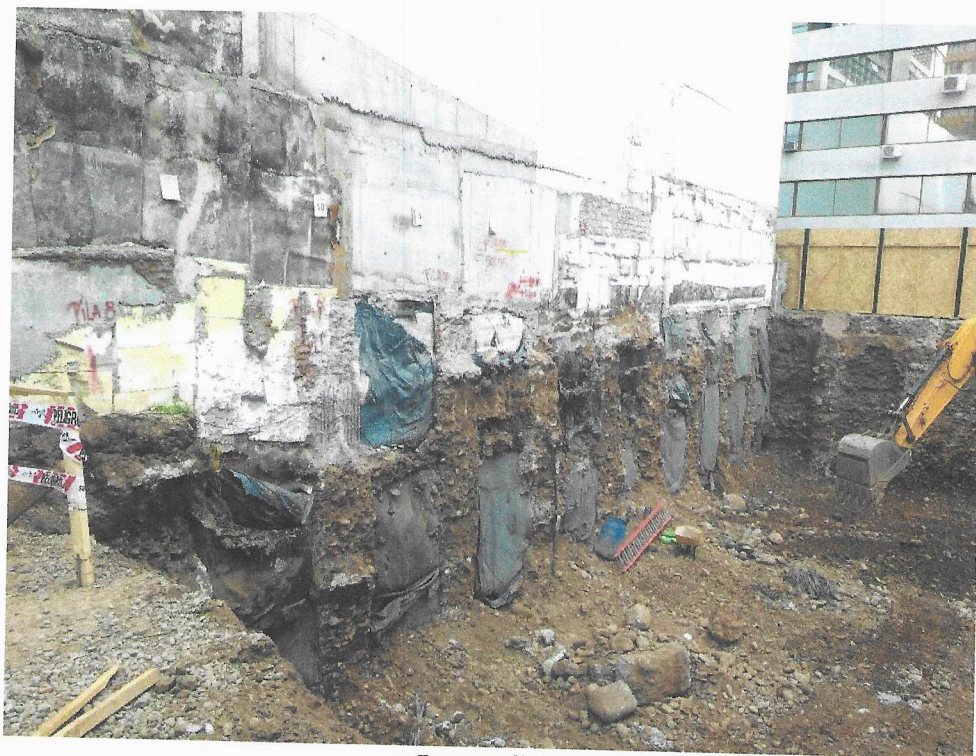
Fotografía 3: Descubrimiento pilas deslinde sur
