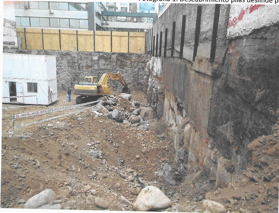
Fotografía 2: Descubrimiento pilas deslinde norte
