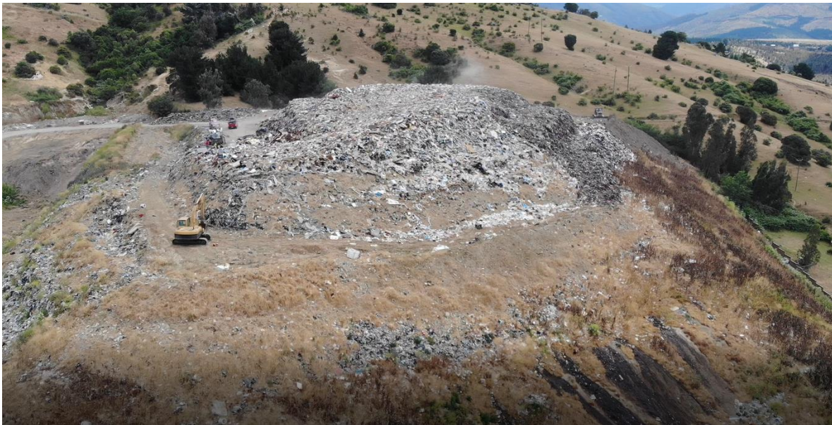
Figura 5: Zona Acopio Vertedero. Fuente: DSS.
