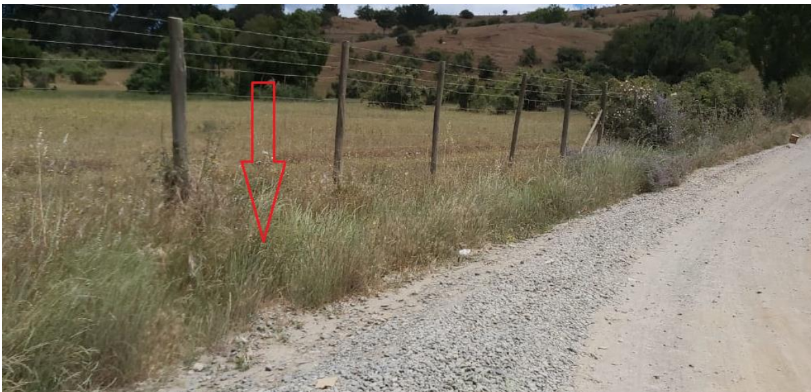
Figura 11: Canalización aguas lluvia. Fuente: DSS.
