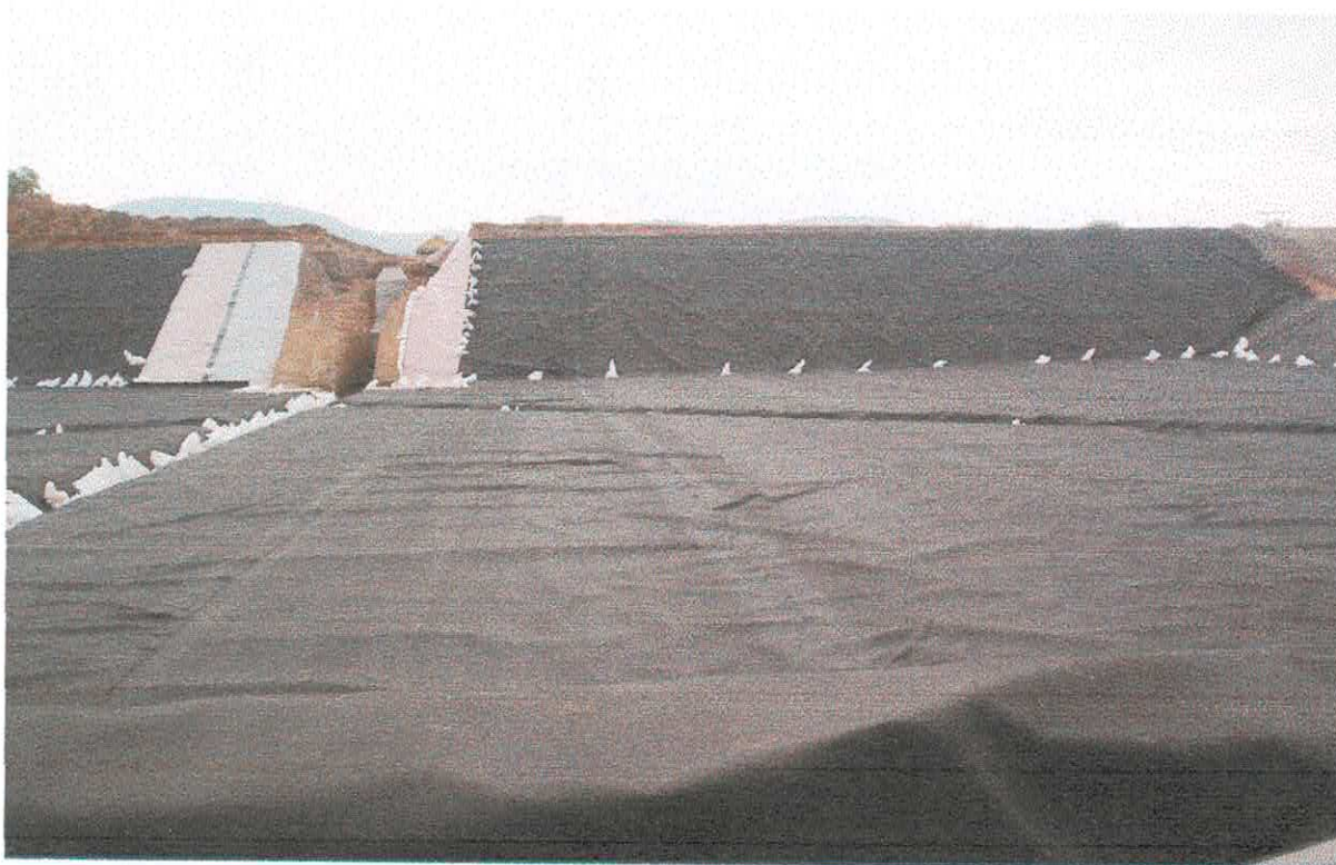
Foto 18: Superficie Impermeabilizada (02.05.2005).
