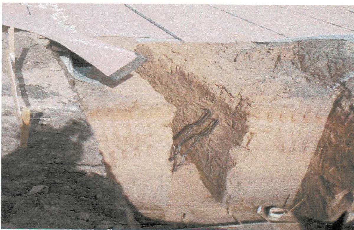
Foto 19: Zanja de la tubería de captación de lixiviados (entre el relleno y la primera cámara de inspección (18.04.2005).
