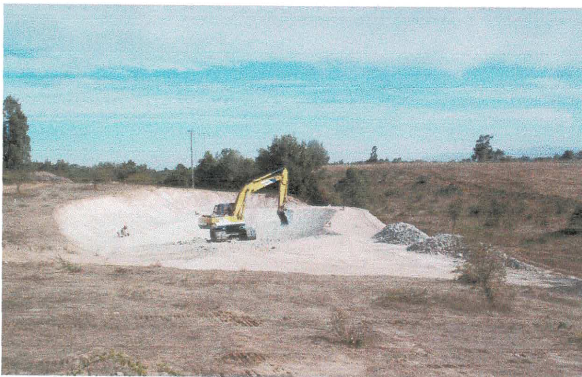
Foto 21: Excavación de la piscina de acumulación de lixiviados (18.04.2005).
