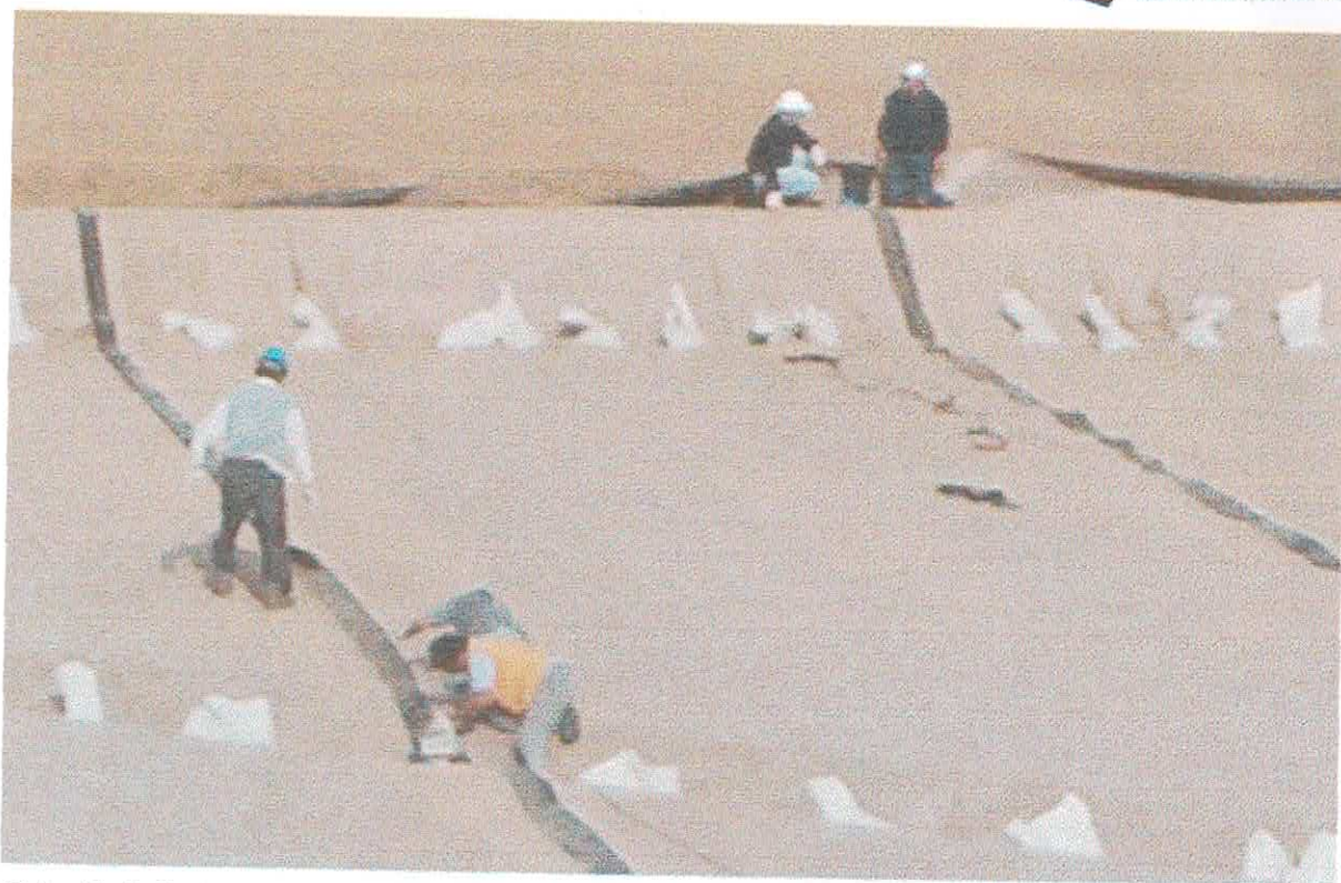
Foto 16: Sellado de las Geomembranas de PEAD (18.04.2005).
