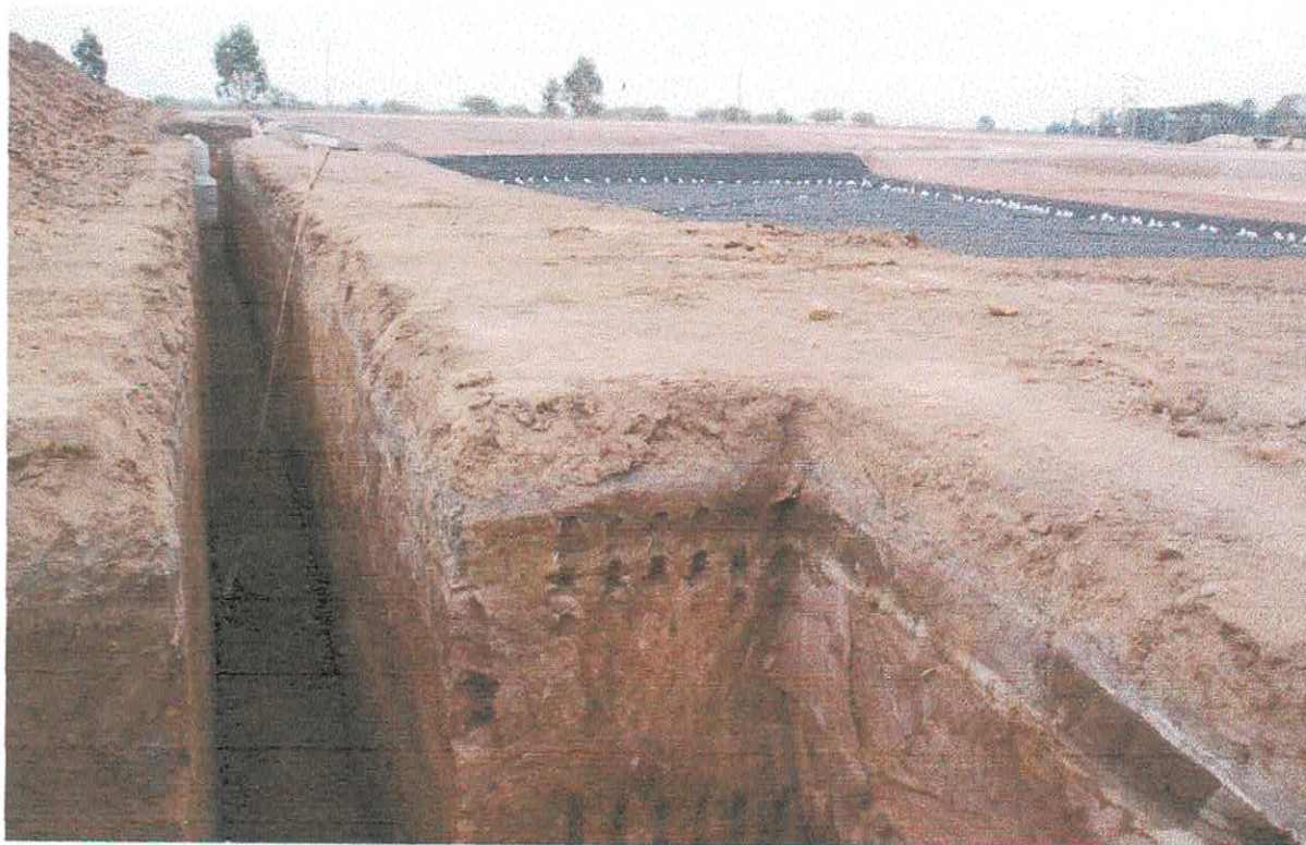
Foto 20: Zanja de la tubería de evacuación de lixiviados, entre la primera y segunda cámara de inspección (02.05.2005).
