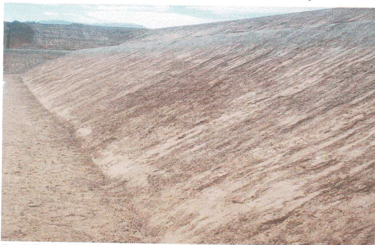
Foto 14: Taludes del Primer Sector de Disposición - Superficie libre de bolones y/o piedras gruesas (18.04.2005).
