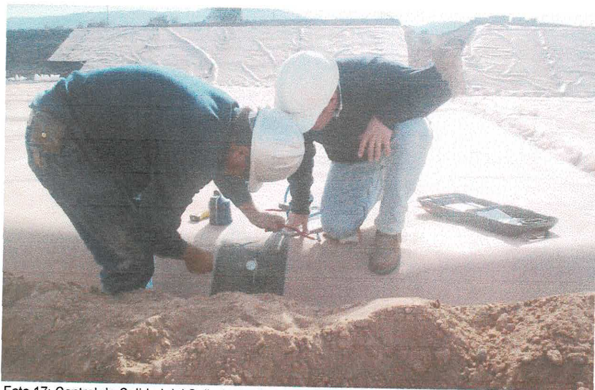
Foto 17: Control de Calidad del Sellado de Geomembranas efectuadas por la empresa MEMBRANTEC y laboratorio externo IDIEM (18.04.2005).
