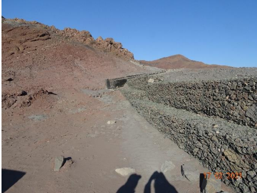
Fotografía N°4: Estado actual Vertedero de Seguridad de Aguas Lluvias en TR1
