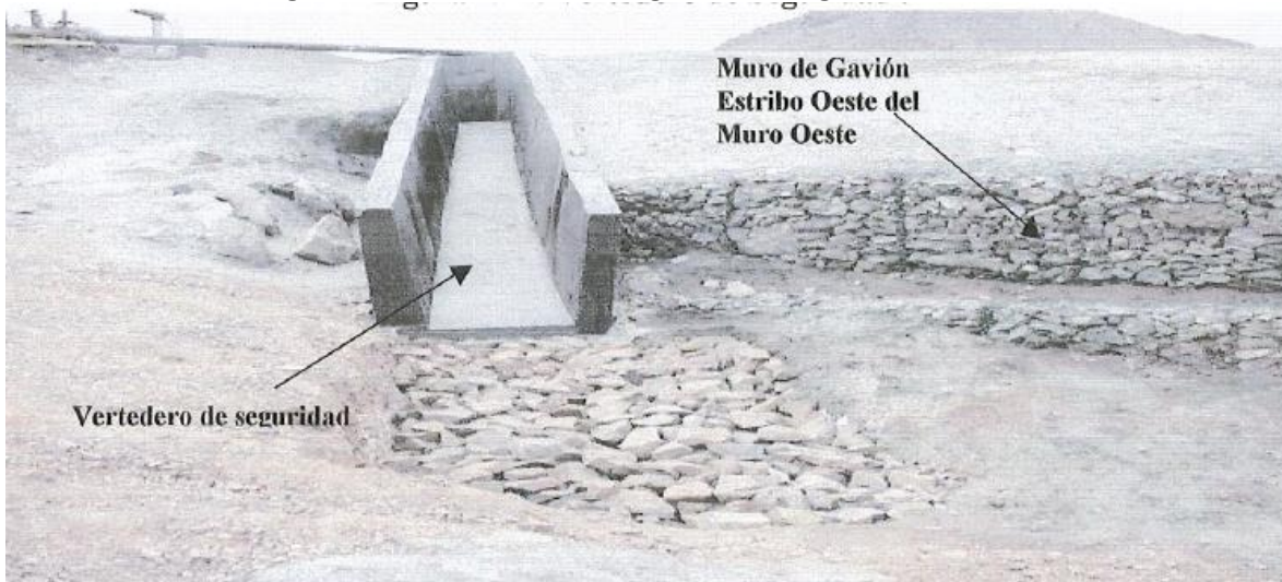
Fotografía N°1: Vertedero de Seguridad de Aguas Lluvias en TR1
