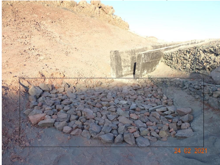
Fotografía N°7: Estado actual Dissipador de Energía en TR1
