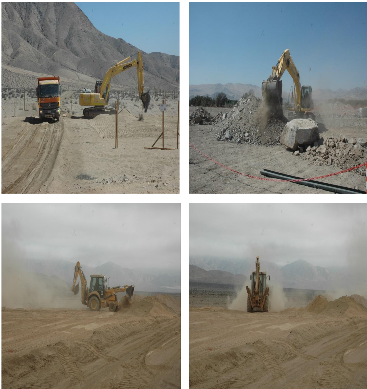
Figura 33: Las imágenes superiores detallan la extracción del material edáfico utilizando retroexcavadora y las inferiores el acopio del escarpe utilizando una miniretroexcavadora. La imagen superior derecha detalla el acopio temporal sobre malla de geotextil, en cambio, las imágenes restantes el acopio en áreas denudadas dentro de la franja de servidumbre (luego del pretil del camino=polygonos de revegetación).
