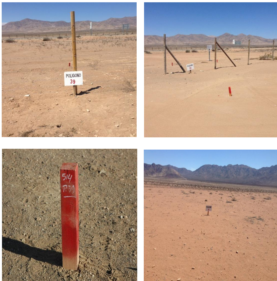
Figura 32: Las imágenes detallan los polígonos de escarpe establecidos en terreno. En las fotografías superiores la señalética y demarcación en terreno. Las inferiores, detallan el tocón utilizado para delimitar los polígonos (previo al escarpe) y las zonas denudadas escogidas para la disposición del material.
