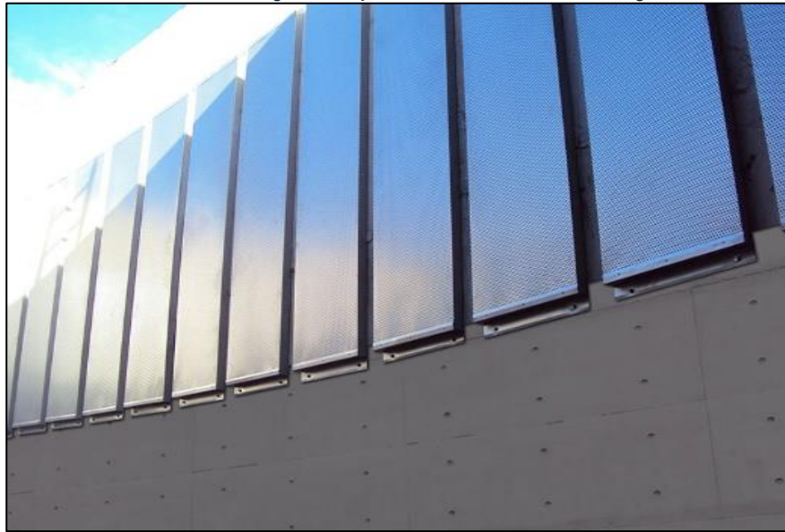
Ilustración 11: Imagen descriptiva silenciador resistivo rectangular.
