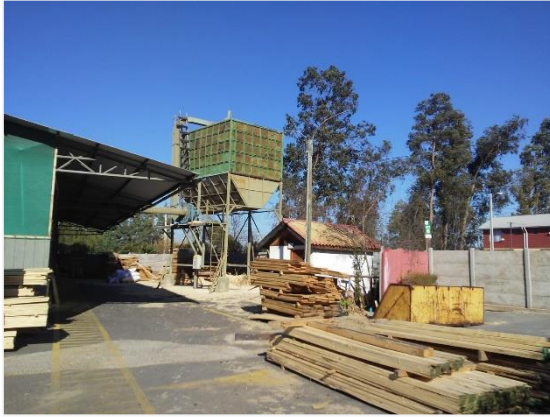
Extracción de aire
