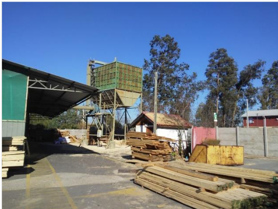
Extracción de aire
