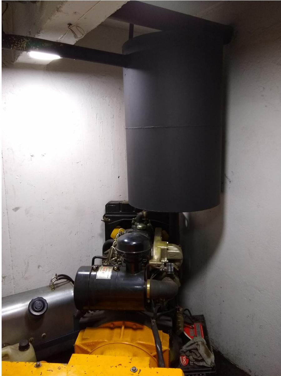
**Figura 2:** Grupo electrógeno con soluciones constructivas implementadas por parte de Ceacústica limitada.
