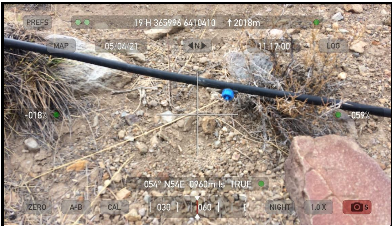
Sistema de riego en buen estado.
