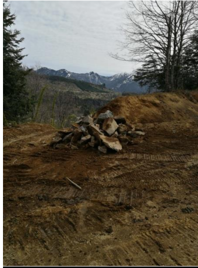
Figura 13: Trabajos Terratecnia 25-09-2017 Toma 3.
