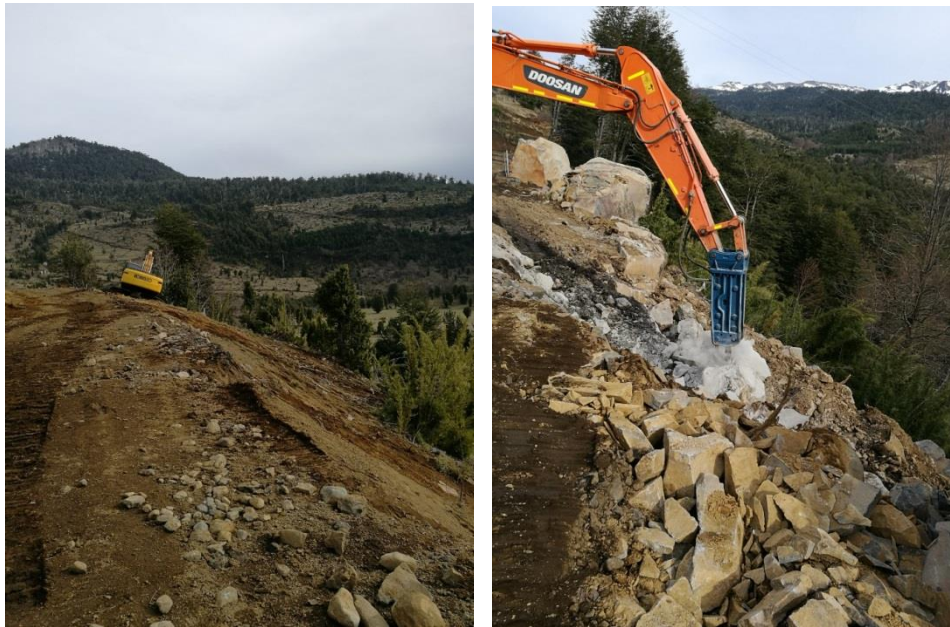
Figura 8: Trabajos Terratecnicia 21-09-2017 Toma 1 y 2
