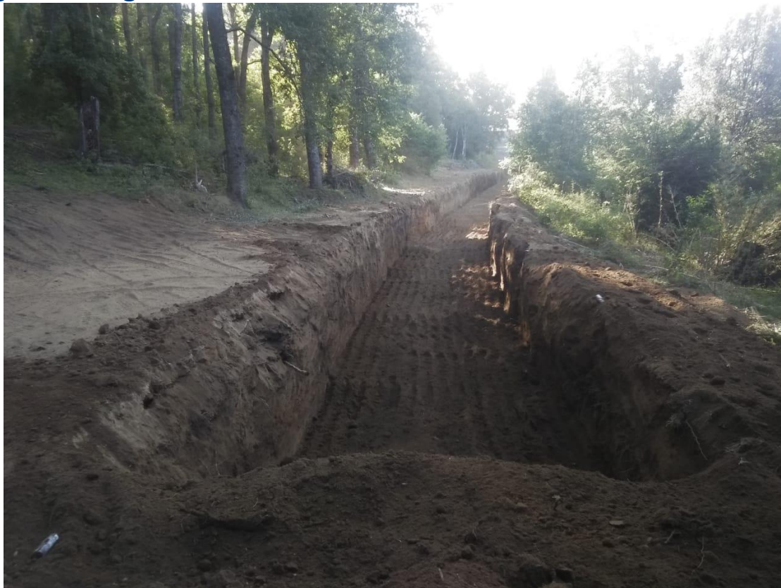
Fotografía N°1: Excavación tramo J
