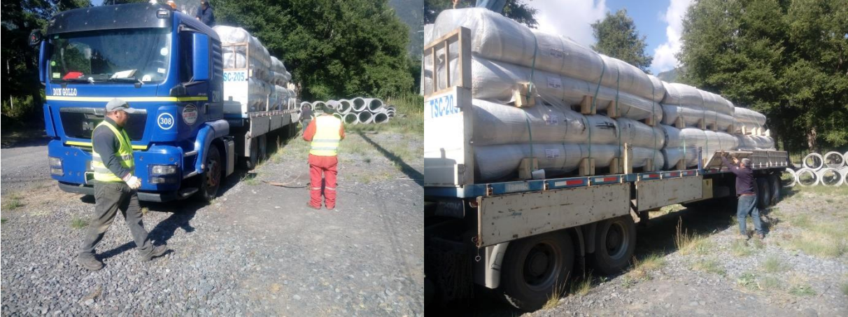
Recepción de materiales, descarga y acopio en instalaciones de Central de Pasada Carilafquen Malalcahuello
