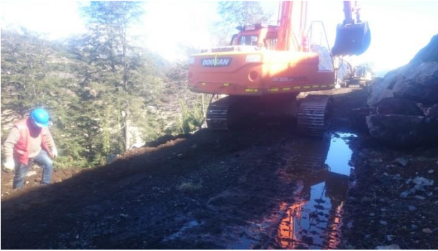
Figura 6: Trabajos Terratecnia 16-09-2017 Toma 1
