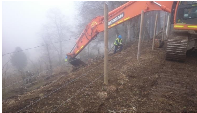
Figura 3: Trabajos Terratecnia 13-09-2017 Toma 2
