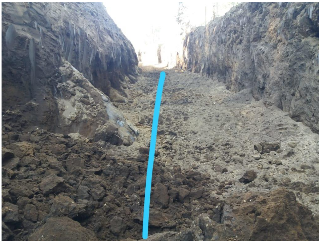
Fotografía N°4: Excavación tramo D
