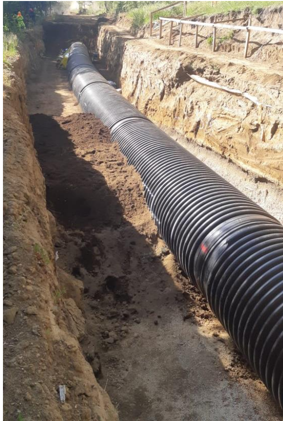
Fotografía N°3: rellenos tramo F.
