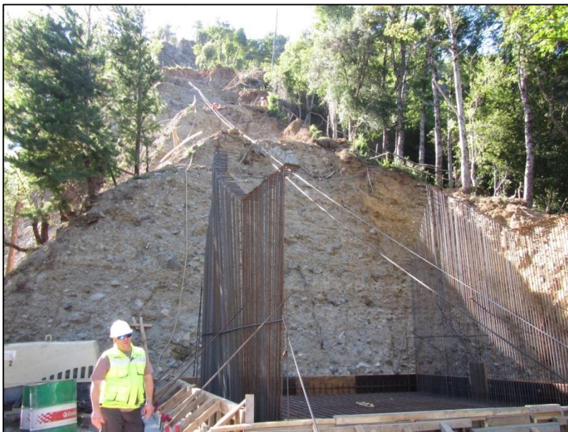
Fotografía 5-3: Excavación de ladera en materiales no consolidados de origen glacial, vista B (depósitos morrénicos).
