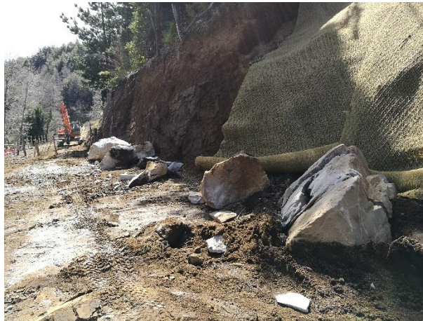
Figura 15: Trabajos Terratecnia 27-09-2017 Toma 1.
