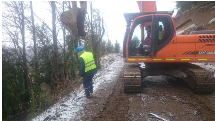
Figura 4: Trabajos Terratecnia 14-09-2017 Toma 1
