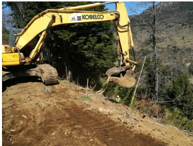
Figura 14: Trabajos Terratecnia 26-09-2017 Toma 1.
