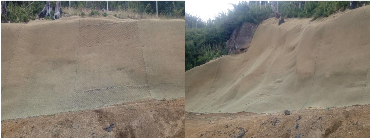
Mallas instaladas en Aducción Carilafquen con Mallas Greenax pk 680 aprox Punto 10 UTM coordenadas 282.738, 5.690.786
