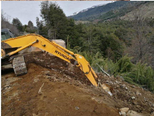
Figura 12: Trabajos Terratecnia 25-09-2017 Toma 1 y 2.
