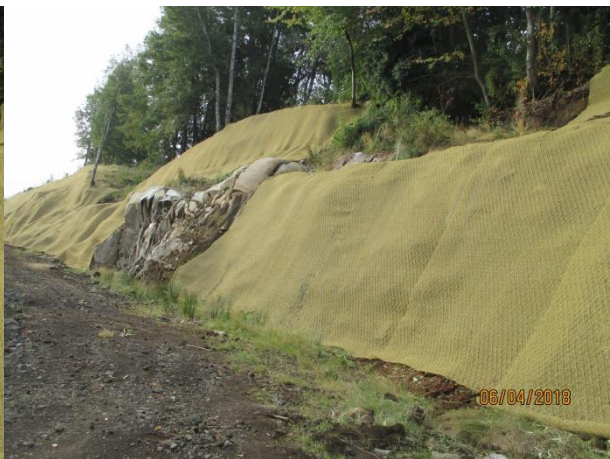
Mallas instaladas en Aducción Carilafquen con Mallas Greenax pk 200 al pk 600 (Servidumbre A. Pardo) Punto 7 UTM coordenadas 282.878, 5.690.610
