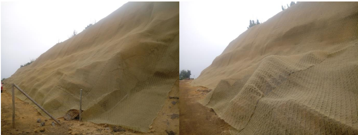
Mallas instaladas en Aducción Carilafquen con Mallas Greenax pk 200 al pk 600 (Limite Servidumbre A. Pardo) Punto 8 UTM coordenadas 282.811, 5.690.661
