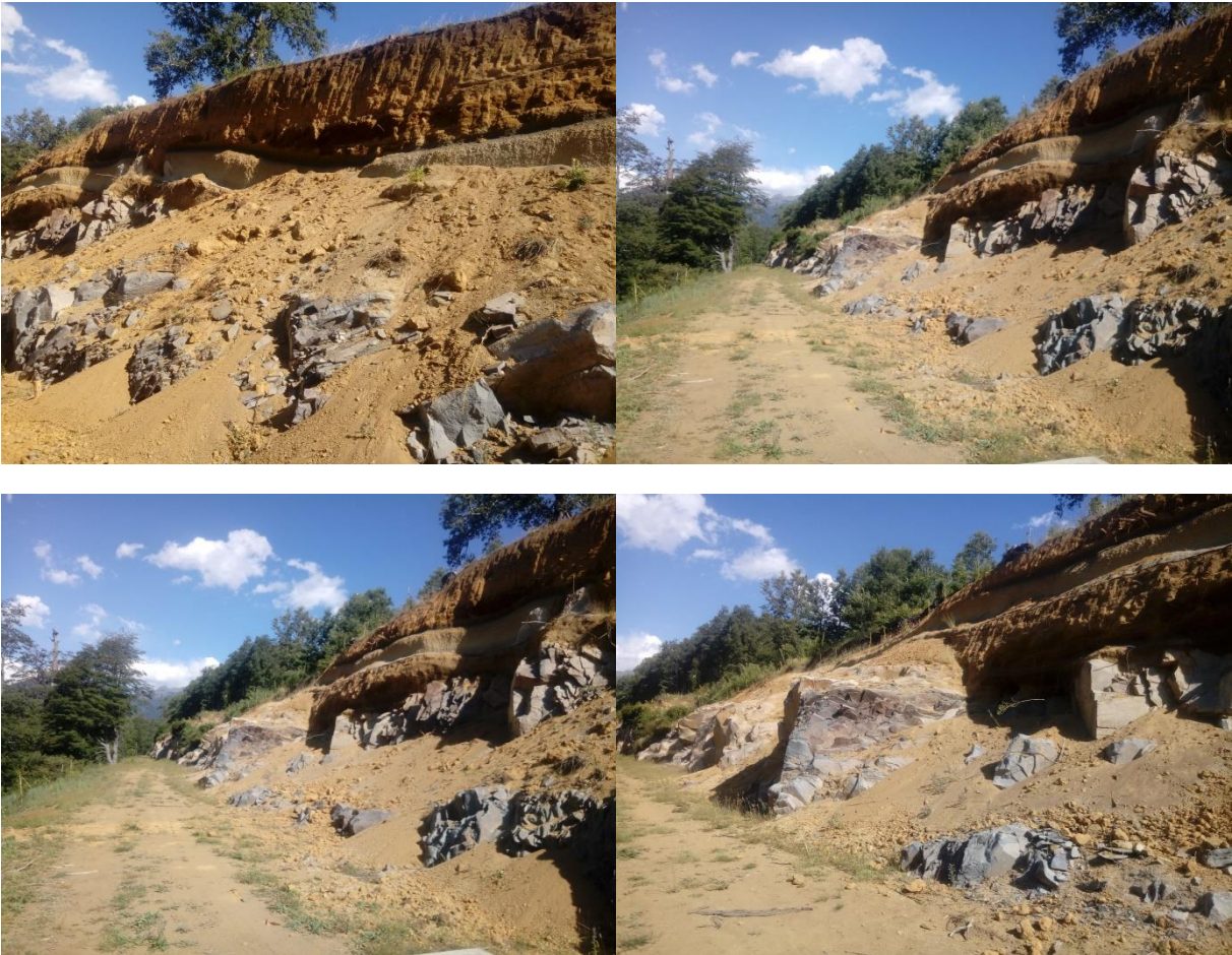
Trabajos de Preparación de Taludes para instalación de Malla Greenax en Aducción Malalcahuello pk 1250 al pk 1450 aproximado. (Punto 3 UTM coordenadas 283.050, 5.692.297)
