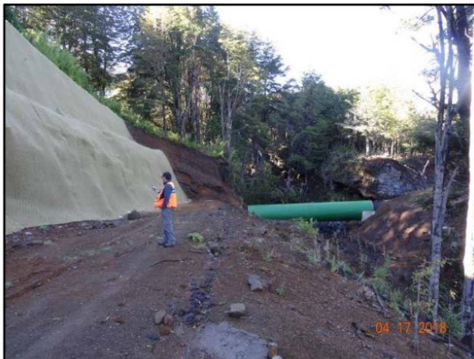
Figura N° 7.2 Imagen N°3 SMA – PK 0+160
