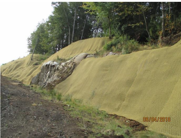
Mallas instaladas en Aducción Carilafquen con Mallas Greenax pk 200 al pk 600 (Servidumbre A. Pardo) Punto 7 UTM coordenadas 282.878, 5.690.610
