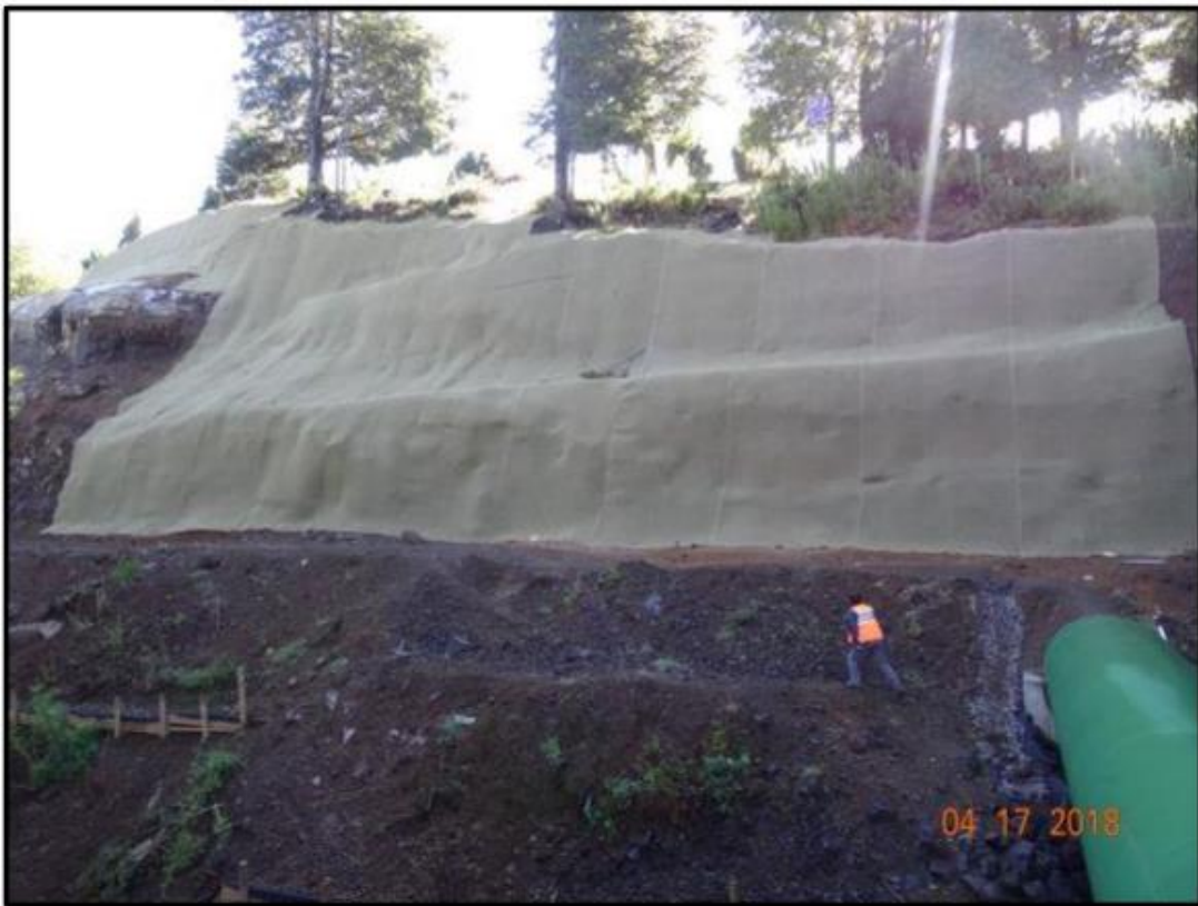
Figura N° 7.1 Imagen N°2 SMA – PK 0+160
