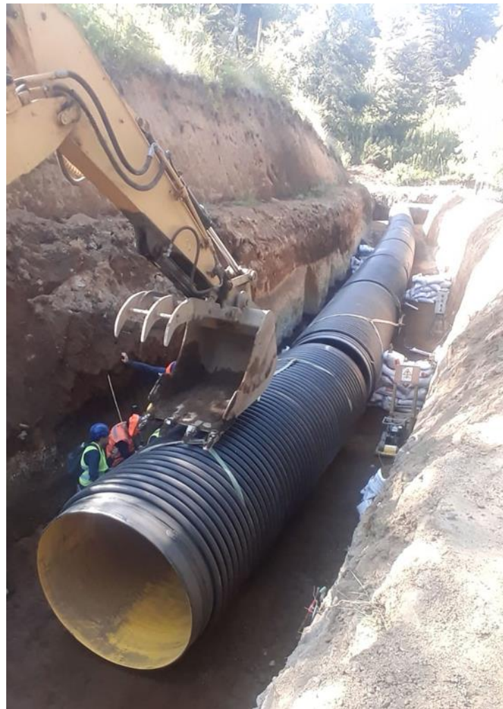
Fotografía N°7: Montaje tramos C
