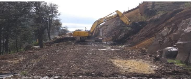
Figura 10: Trabajos Terratecnia 23-09-2017 Toma 1 y 2.
