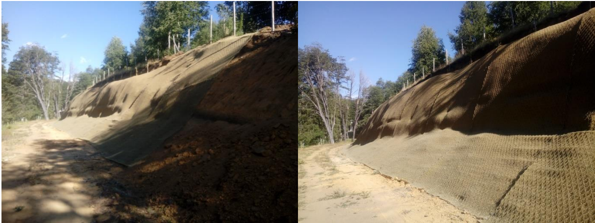
Mallas instaladas en Aducción Malalcahuello pk 70 al pk 170 Punto 2 UTM coordenadas 283.664, 5.692.408
