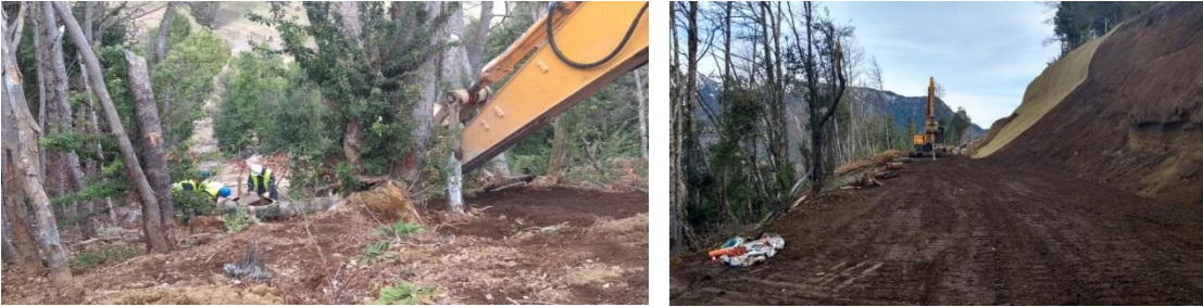
Figura 11: Trabajos Terratecnia 23-09-2017 Toma 3 y 4.
