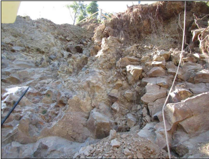
Fotografía 5-4: Excavación de ladera en materiales rocosos.
