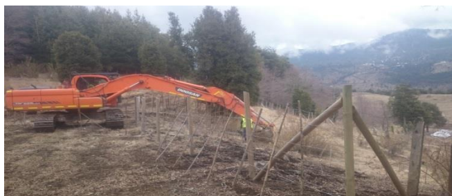
Figura 2: Trabajos Terratecnia 13-09-2017 Toma 1
