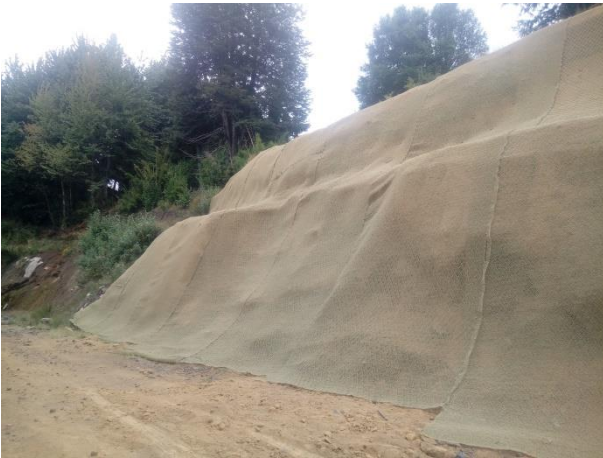
Mallas instaladas en Aducción Carilafquen con Mallas Greenax pk 200 al pk 600 (Servidumbre A. Pardo) Punto 6 UTM coordenadas 282.730, 5.690.764
