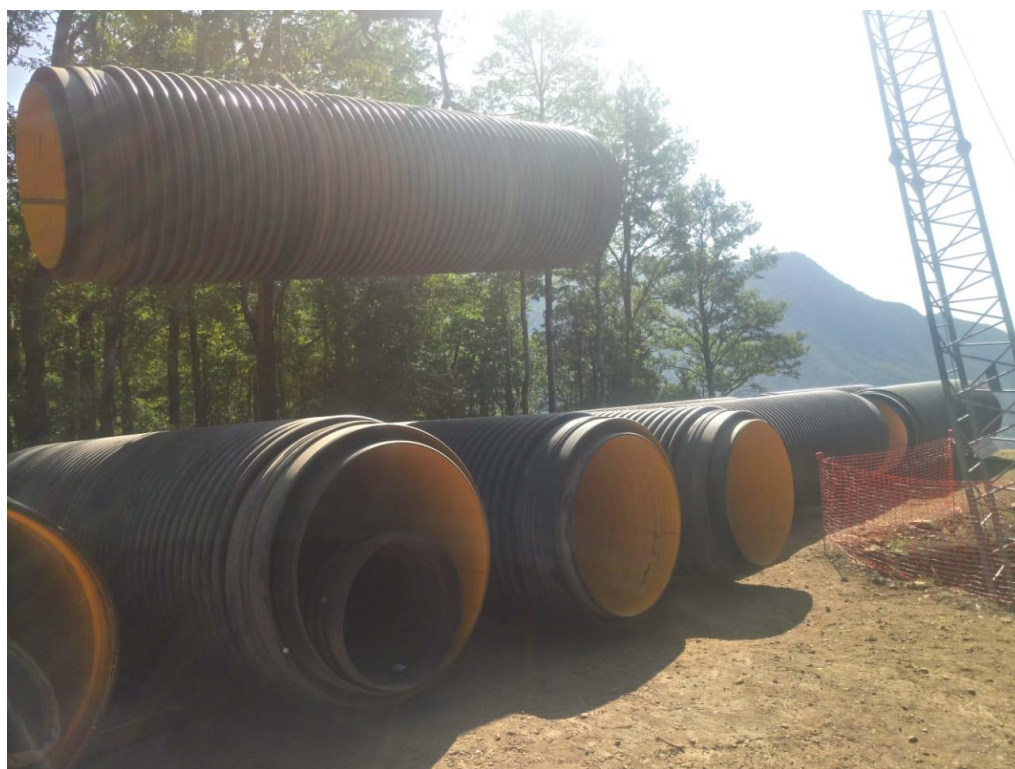
Fotografía N°5: Descarga tubería en torre F3 por teleférico.
