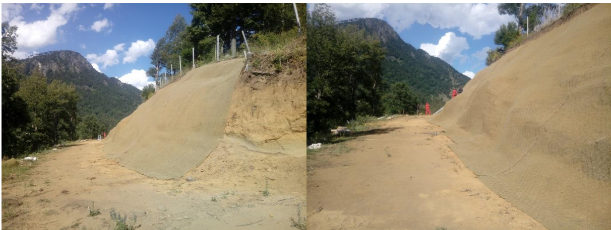
Mallas instaladas en Aducción Malalcahuello pk 1250 al pk 1450 Punto 4 UTM coordenadas 282.955, 5.692.292
