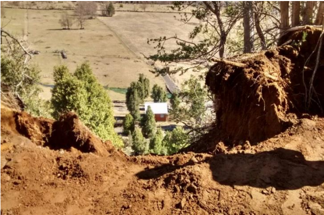
Figura 5: Trabajos Terratecnia 15-09-2017 Toma 1
