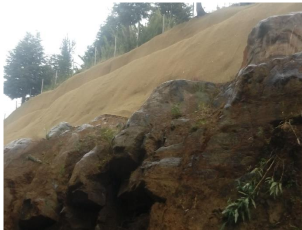
Mallas instaladas en Aducción Carilafquen con Mallas Greenax pk 680 aprox Punto 11 UTM coordenadas 282.707, 5.690.877
