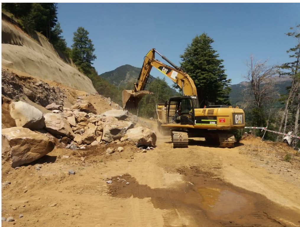
Fotografía N°6: Excavación tramo E
