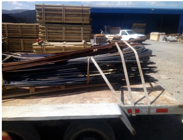
Material de construcción de bastones para instalación de malla Greenax
