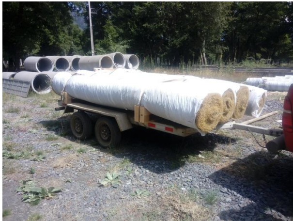
Traslado a punto de acopio cercano a frentes de trabajo desde Ccentral de pasada Carilafquen Malalcahuello
