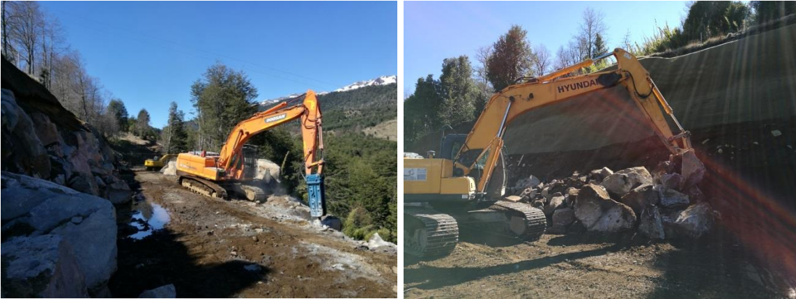
Figura 9: Trabajos Terratecnia 22-09-2017 Toma 1 y 2
