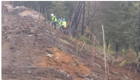
Figura 7: Trabajos Terratecnia 20-09-2017 Toma 1
