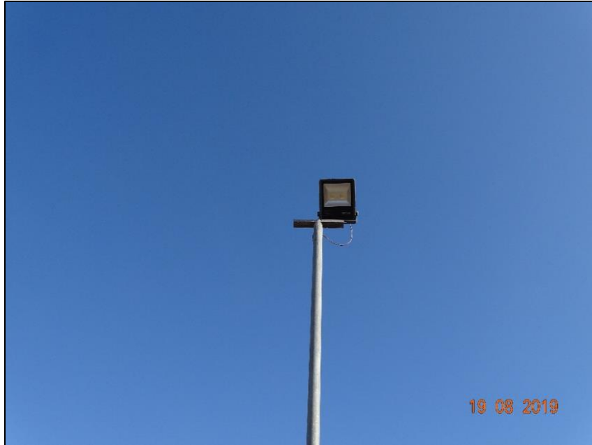
Fotografía 18 Fecha: 19-08-2019 Coordenadas UTM DATUM WGS84 HUSO 19s Norte: 6.687.566 mS Este: 280.663 mE Descripción del medio de prueba: Vista detalle de luminaria LED DARLUX de 160 W.
