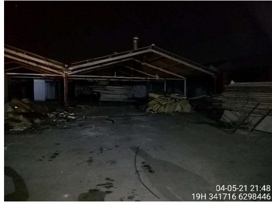
Unidad Inspeccionada sin actividad
