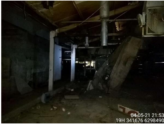
Unidad Inspeccionada sin actividad
