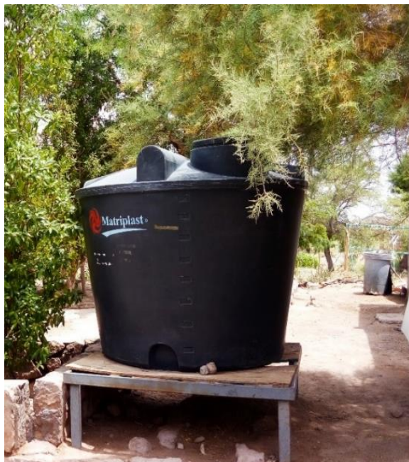
Imagen 30: Estanque plástico de almacenaje de agua. (Fotografía del autor).
