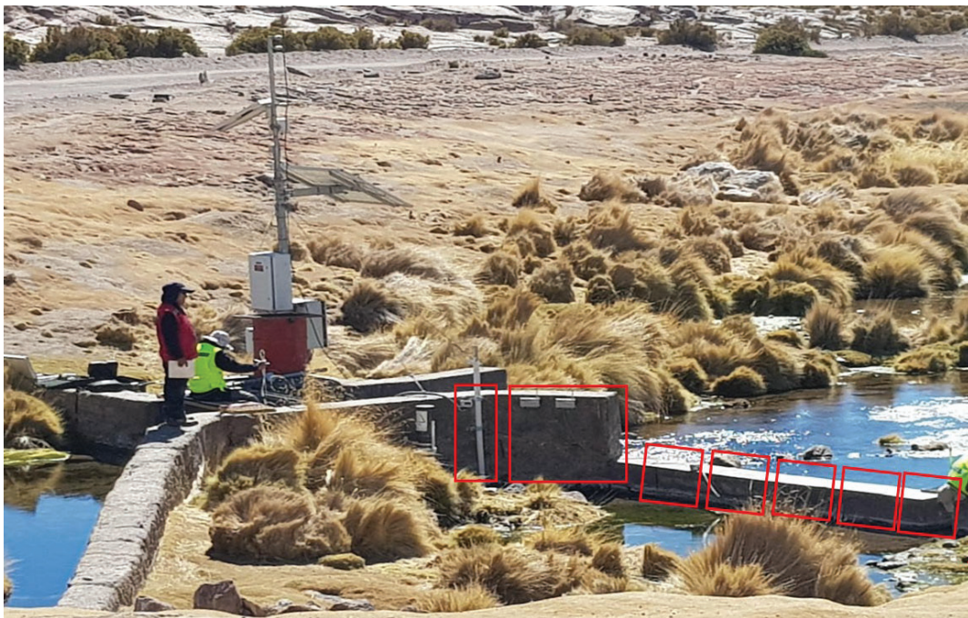
Figura 3 Refuerzo muros vertedero chico
