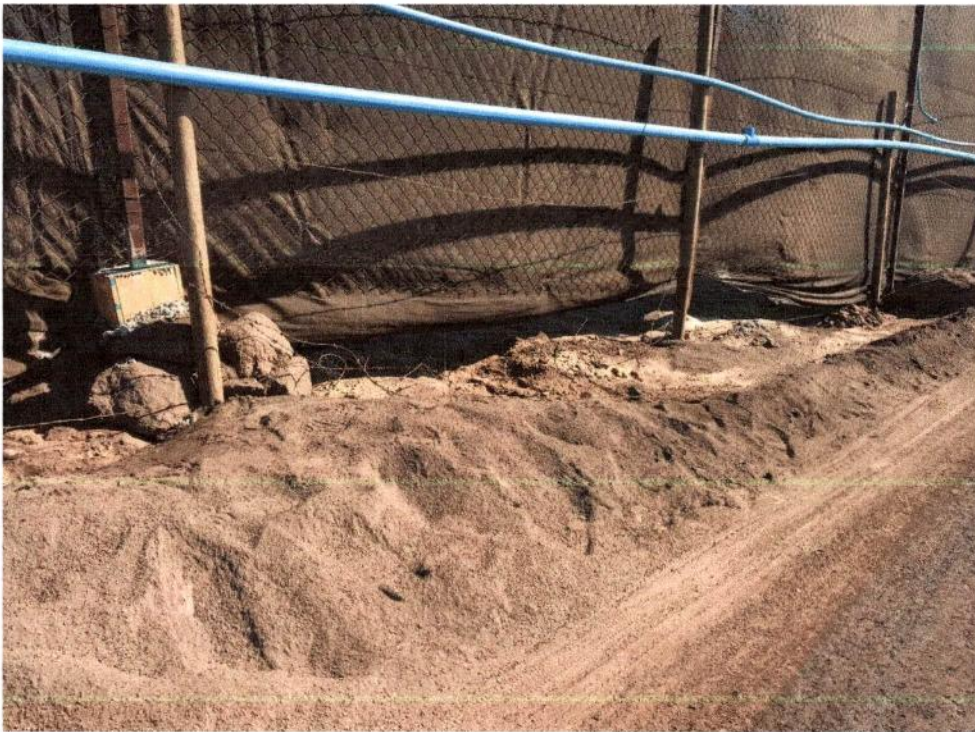
Imagen 25: Foto de inspección faena 10.06.2021 – Cierre suroeste, con apertura en el borde inferior
