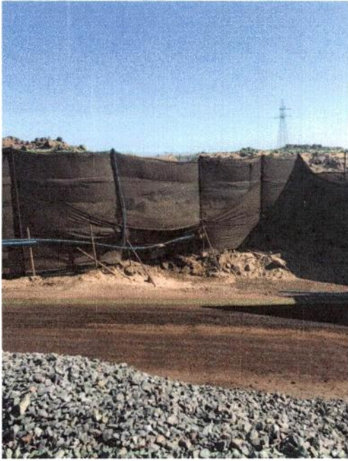
Imagen 20 y 21: Foto de inspección faena 10.06.2021 – Cierre suroeste, en malla raschel y perfiles
