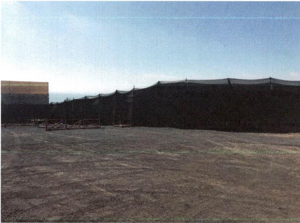
Imagen 33: Foto de inspección faena 10.06.2021 – Cierre Este
