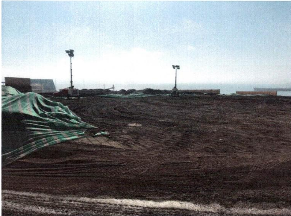
Imagen 13: Foto de inspección faena 10.06.2021 – Acopio material tamaño fino parte superior
