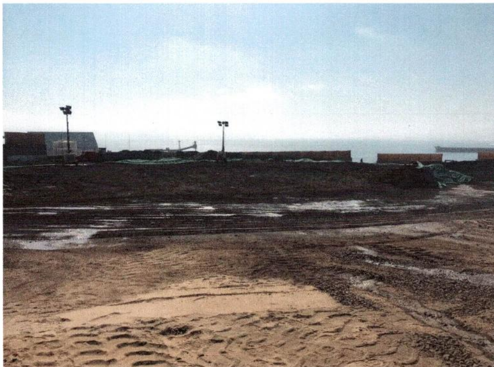
Imagen 14: Foto de inspección faena 10.06.2021 – Acopio material tamaño fino parte superior
