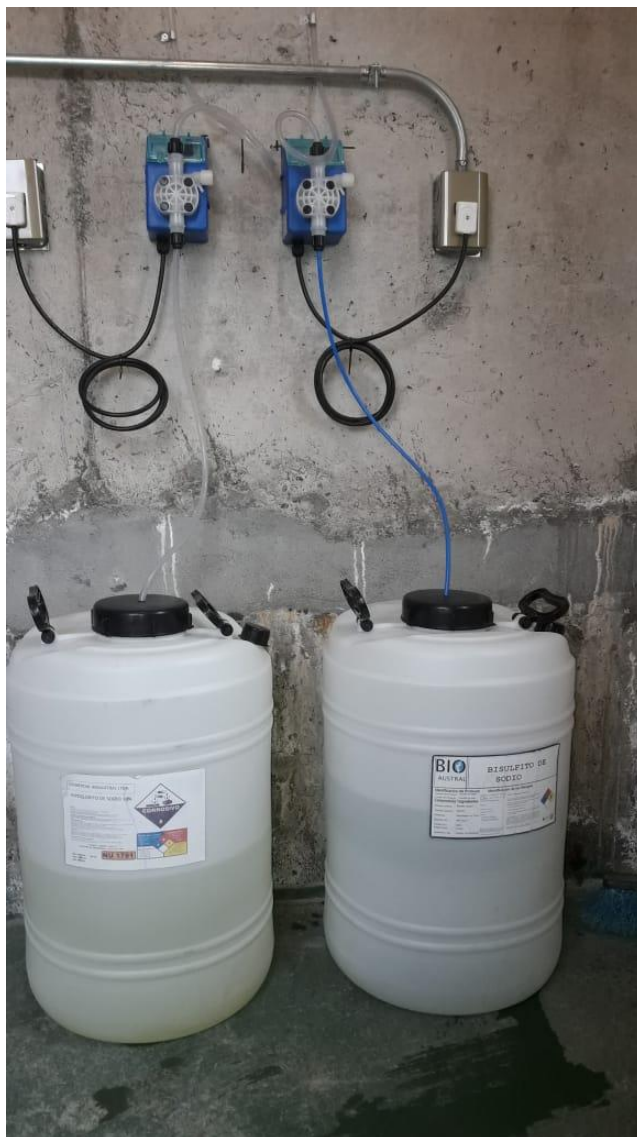
Fotografía 01. Sistema de cloración y decloración instalado en el Sistema de Tratamiento de Aguas Servidas del Hotel Río Serrano.
