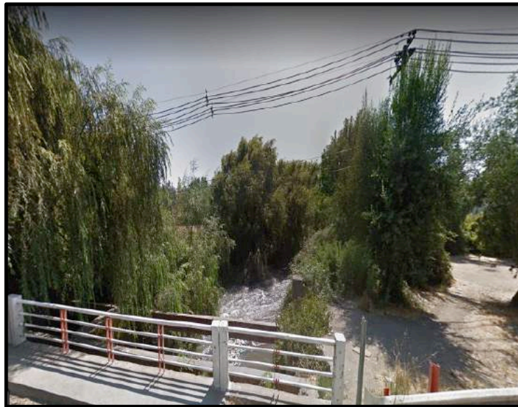
Foto 5. Vista aguas abajo del sector puente El Gato del estero El Gato en el km 10,2. (Fuente: Elaboración propia.)
