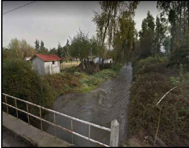
Foto 4. Vista aguas abajo del sector puente Las Parcelas del estero El Gato en el km 7,3. (Fuente: Elaboración propia.)
