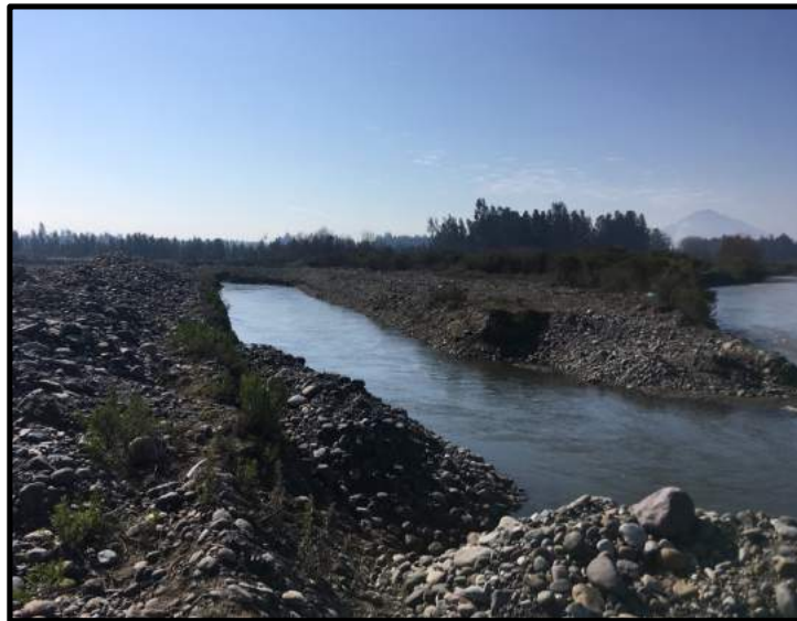
Foto 6. Vista aguas arriba de la desembocadura del estero El Gato en el río Mapo en el km 11,4. (Fuente: Elaboración propia.)
