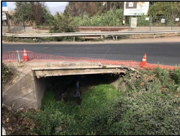
Foto 2. Vista del sector puente Lonquén del estero El Gato en el km 2,2. (Fuente: Elaboración propia.)
