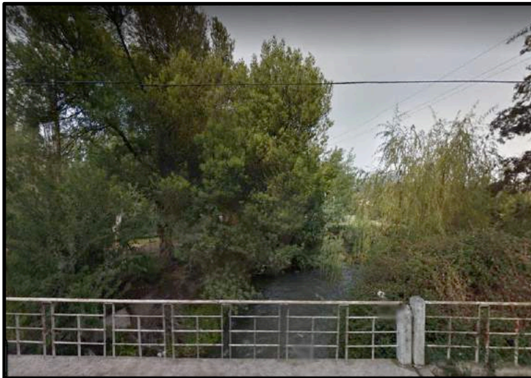
Foto 3. Vista aguas abajo del sector puente Las Parcelas N°2 del estero El Gato en el km 5,6. (Fuente: Elaboración propia.)
