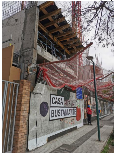
Trabajos losa piso 2
