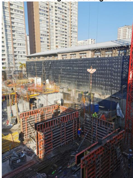
Trabajos en cota 0
