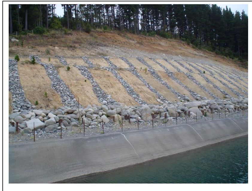
Foto 18: Manejo de taludes conformados por suelos volcánicos (Serie Santa Bárbara) en pendiente media en canal de aducción de centrales hidroeléctricas Mampil y Peuchén, VIII Región. Se construyó drenajes con bolones de piedras y se instaló un muro con los mismos materiales. Se efectuó plantación en los bancos del talud. Desde el punto de vista estético es una solución intermedia ya que las especies arbóreas demoran entre 3 a 6 años en cambiar el paisaje y brindar protección al suelo
