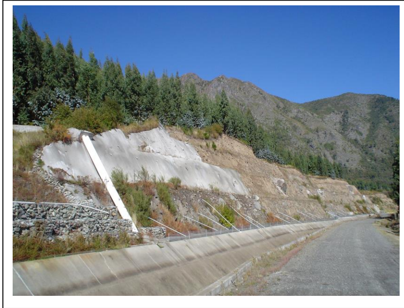
Foto 19: Manejo de taludes en canal de aducción centrales Mampil y Peuchén mediante aplicación de shockcrete, que ha demostrado ser ineficaz (en zonas de alta pluviosidad es objeto de socavaciones) e inaceptable desde el punto de vista estético.
