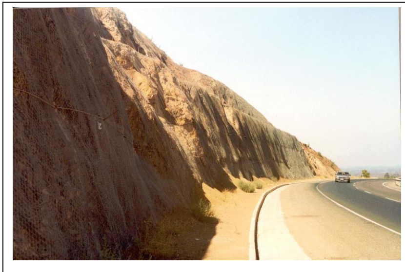
Foto 17: Manejo de taludes de gran pendiente mediante mallas metálicas en autopista Los Libertadores. Las mallas, debidamente ancladas evitan el desmoronamiento y la caída de piedras sobre la calzada, pero desde el punto de vista estético disminuyen drásticamente la calidad del paisaje y del entorno
