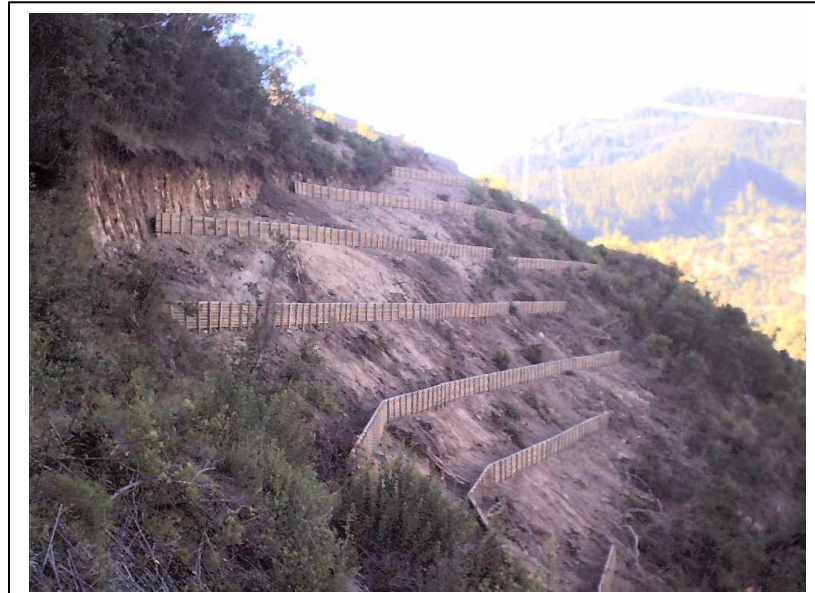
Foto 20: Manejo de taludes y control de erosión mediante muros de polines especificados por el autor de este plan de manejo en faja de línea de transmisión eléctrica, VII Región. Posteriormente se efectuó siembra de especies herbáceas y plantación de especies nativas, combinando de esta manera medidas estructurales y biológicas, más amigables con el medio ambiente y el paisaje.
