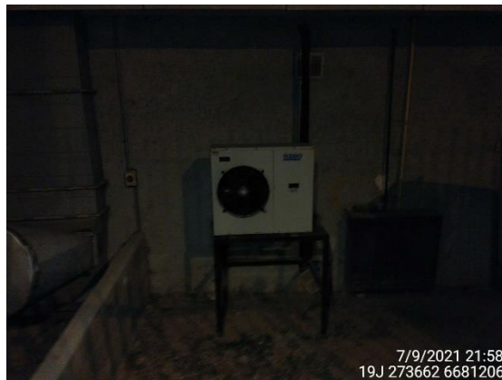
Equipo de aire acondicionado
