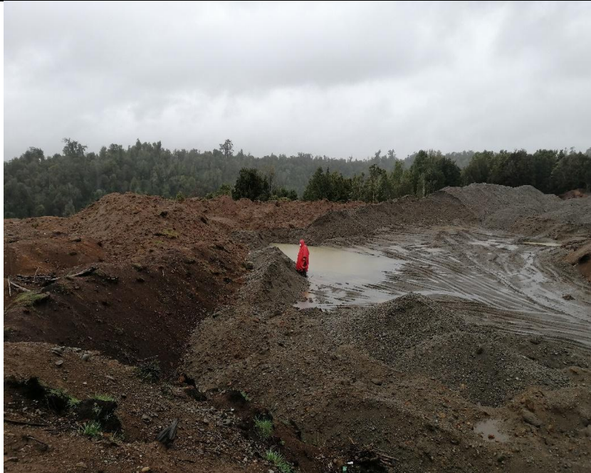
Imagen N° 15, Inspección de porción Este del relleno sanitario, se aprecian acumulaciones de sedimento arcilloso y arenoso.
