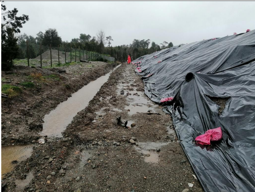
Imagen N° 8, Inspección de porción W del relleno sanitario, se aprecia basura en canal y protección en mal estado.
