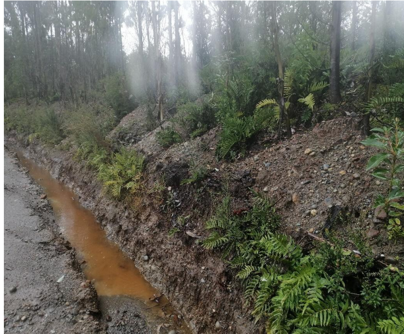
Imagen N° 21, Inspección de acceso vehicular a relleno sanitario, se aprecian sedimentos arcillosos y arenosos acumulados a un costado de la ruta.
