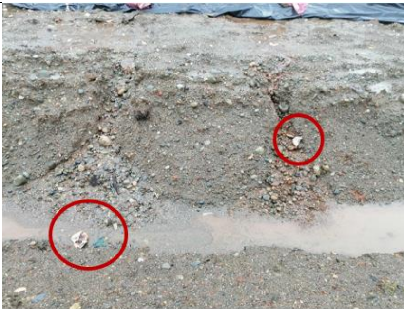
Imagen N° 10, Inspección de porción W del relleno sanitario, basura (plásticos) en canal.
