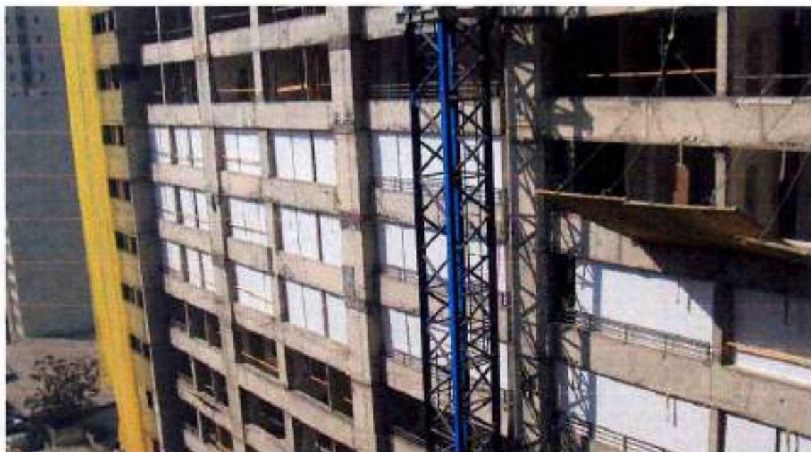
Figura 5. Imagen referencial edificio con cierre de vanos.
