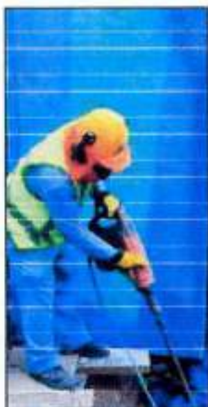
Fig. 1 – Trabajador utilizando blombo acústico.
