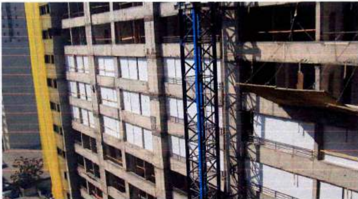
Figura 7. Imagen referencial edificio con cierre de vanos.
