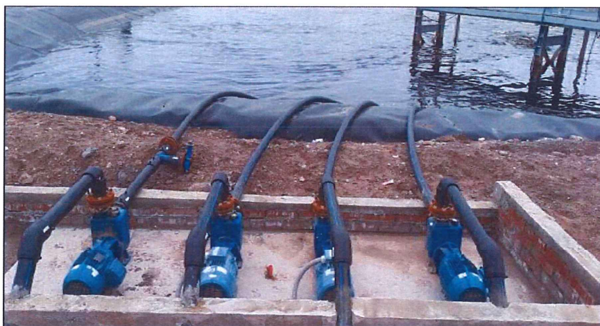
Imagen 5. Bombas de Traspaso de Reactor Anóxico a Reactor Aeróbico N°1
