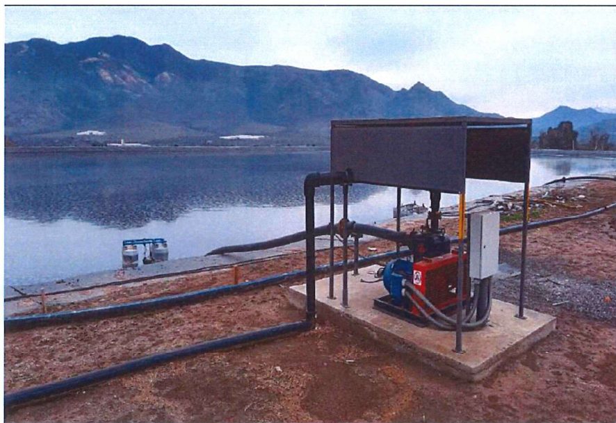
Imagen 2. Bomba de afluente a PTL
