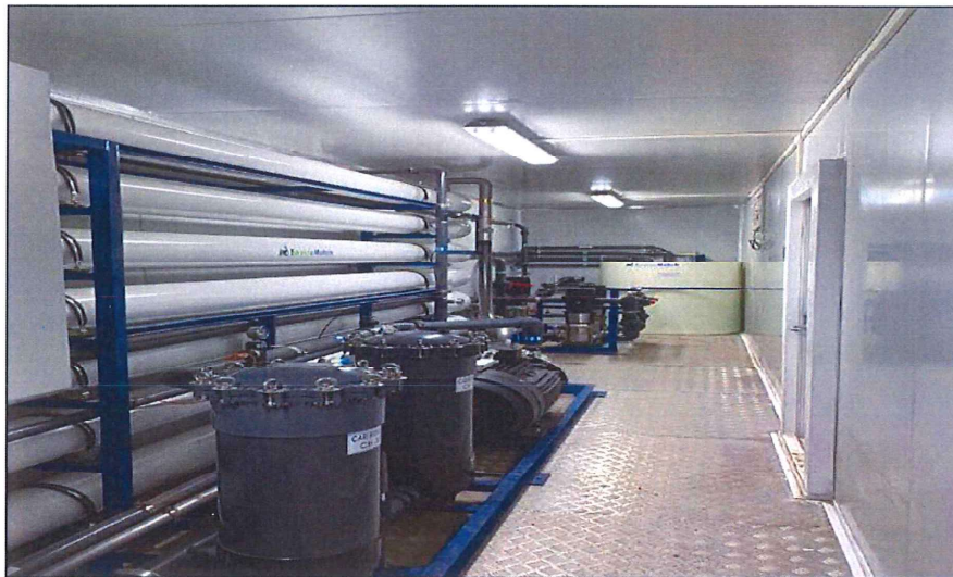
Imagen 11. Sistema de Osmosis Inversa
