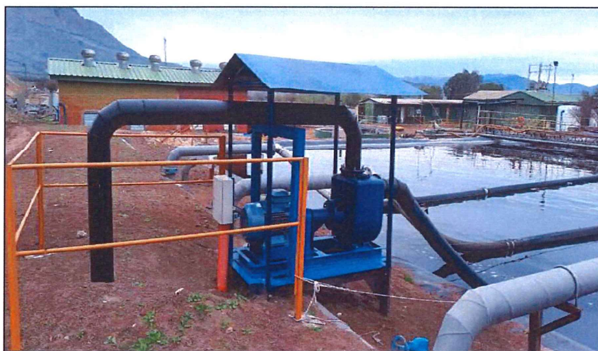
Imagen 7. Bomba de Traspaso Entre Reactores Aeróbicos
