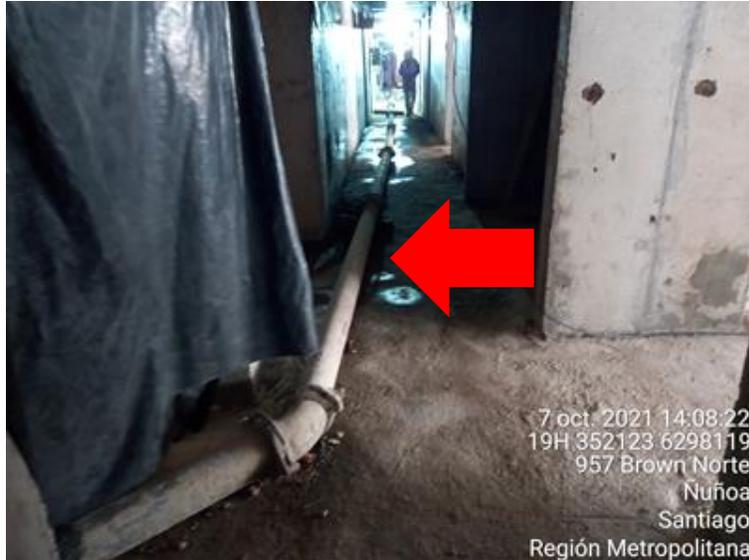
Hasta que finalice la obra gruesa del Proyecto, se priorizará esta configuración de las tuberías de la bomba de hormigón, de manera de que se mantenga alejado el instrumento emisor de ruido respecto a los receptores sensibles cercanos.
