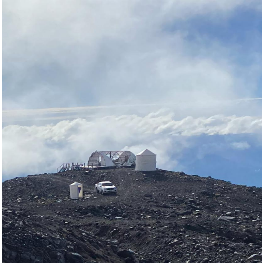
Imagen del lugar con obras en desuso y zanja en su parte inferior
