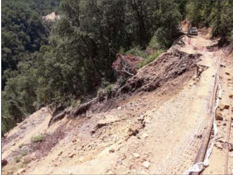
Figura 2-2. Vista del deslizamiento del Talud 2 Pk 1+190 a 1+230. Vista desde el camino vecinal.
