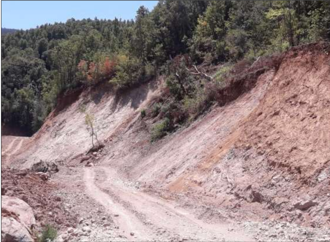
Figura 2-1. Vista general del talud 1 Pk 0+400 a 0+450. Vista hacia el Norte.
