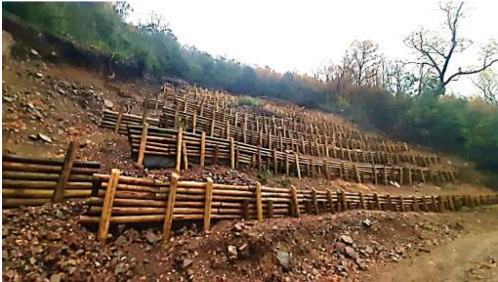
Figura 2-5. Vista 2 de Microterrazas ejecutadas en Talud 2 Pk 1+190 a 1+230. Vista desde el camino del proyecto.
