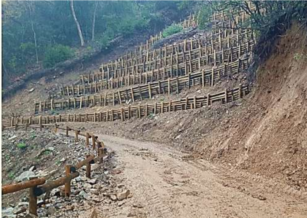
Figura 2-4. Vista 1 de Microterrazas ejecutadas en Talud 2 Pk 1+190 a 1+230. Vista desde el camino del proyecto.
