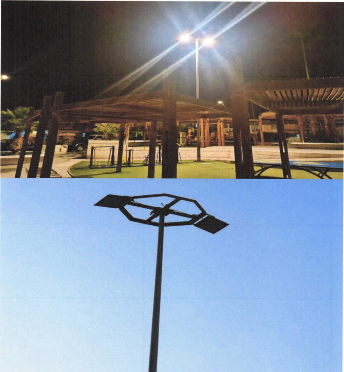
Imagen N°1 y N°2: Instalacion de 8 luminarias que cumplen con el DS43 que fueron adquiridas por la municipalidad de mejillones debido al incumplimiento normativo del DS 43 y el angulo fue corroborado por el contratista y en una eventual revision de la SMA podra corroborar que el angulo de instalacion de las luminarias es el correcto
