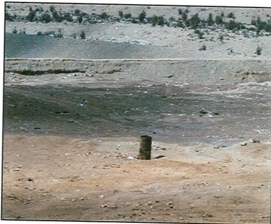
Sistema de Ventilación de gases in situ
