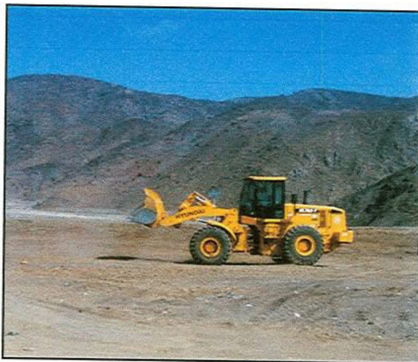
Labores de Recubrimiento realizada por el Cargador Frontal
