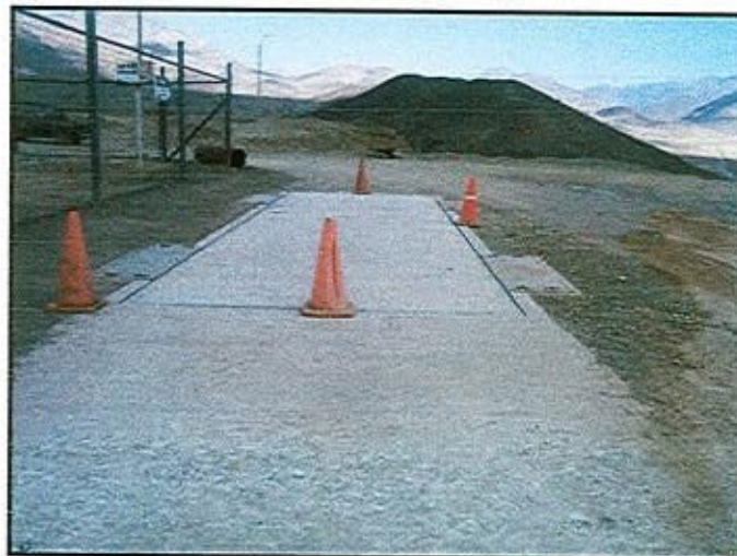
Sistema de Control de Pesaje en funcionamiento
