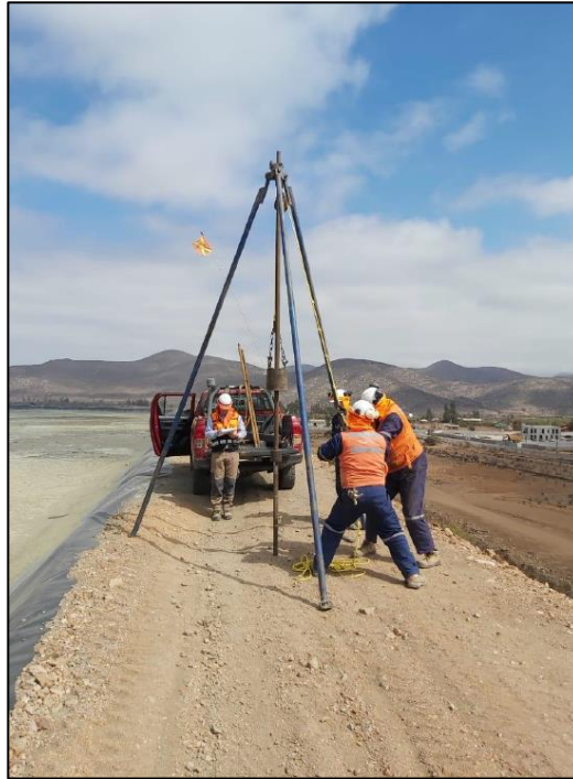
Figura 4: Ejecución de ensayos de penetración tipo “CPT” por parte de DPI Ingenieros.
